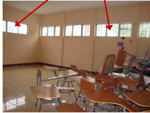
Ventanas Colindantes con propiedades Vecinas
