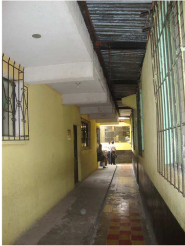
Corredor en Primer Nivel
