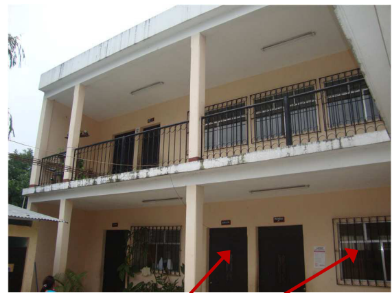
Elementos en Metal (Barandas, Puertas y Balcones)
