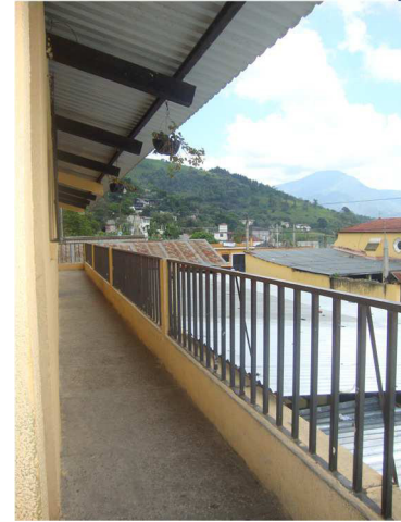
Corredor en Segundo Nivel
