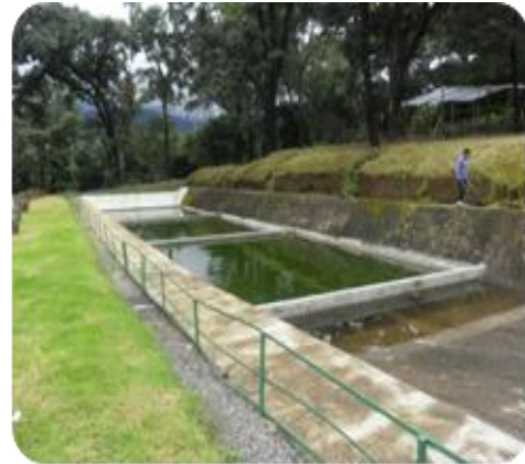
IMAGEN No.1 ESTANQUES EN TERRENO FINCA MUNICIPAL FLORENCIA AUTOR: KAREN COY CÁMARA DIGITAL. 12/08/2010.
