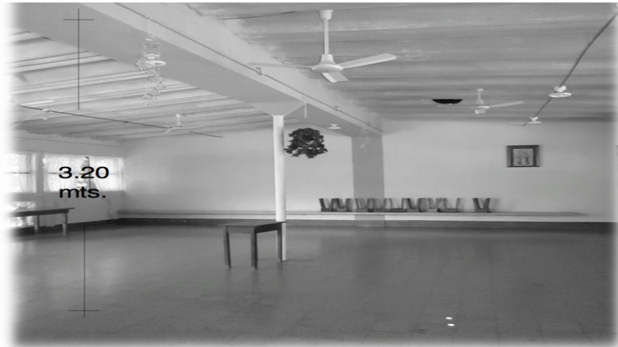
Fotografía No. 2: Espacio que es utilizado por las primeras horas del día para impartir cursos cuando la temperatura ambiental lo permite, por su poca altura y ventilación es poco confortable. Fuente: (Propia)
