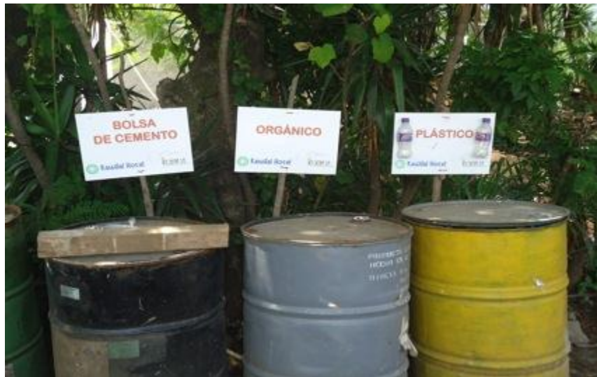
Fotografía No. 15: En la obra se cuidó cada uno de los desechos y para ello se capacitó a todo el personal, para poder clasificarlos y hacer más fácil su reutilización.
