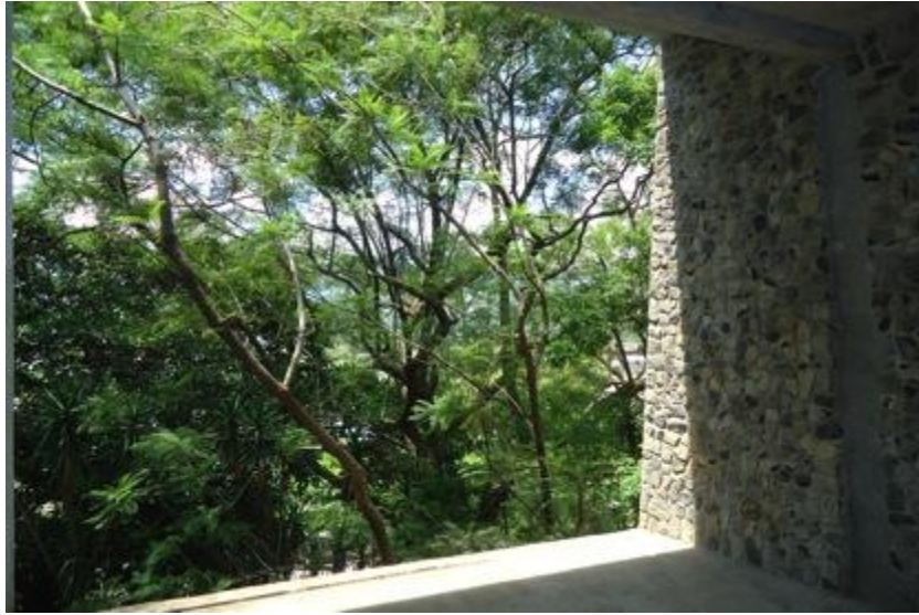
Fotografía No. 14: En los muros se utilizó la misma piedra que se utilizó en la construcción original, aunque la piedra no es de la región. Lo que afecta a la hora de valorar el Co2 producido en el traslado de este material, pero se trato de balancear al reducir los viajes al reusar la tierra del movimiento de suelos. Fuente: Fotografía propia.
