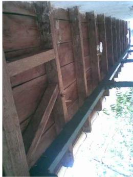
Artesonado de tablas con la estructura de madera labrada
