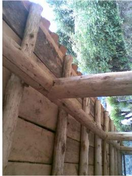
Artesonado de tablas con la estructura de madera sin labrar
