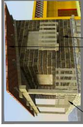
**Adobe:** Es un ladrillo hecho con barro que tiene, tradicionalmente, unas 10" x 14" x 4" pulgadas. La mezcla ideal contiene un 20% de arcilla y un 80% de arena. Cuando parte del agua se evapora, el ladrillo es capaz de sostenerse por sí mismo. Después de varios días, para acelerar el secado, los ladrillos son movidos, apoyándose en una de sus caras laterales. La cura completa toma unos 30 días. Es entonces cuando el ladrillo es tan fuerte como el cemento.
