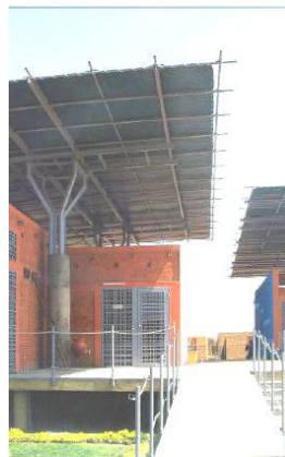
Fig. 3.1. Estructura de Acero, protegida con malla impermeable ligera de pvc
