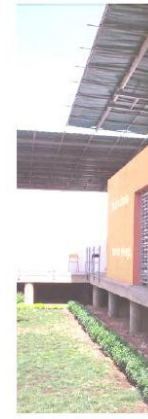
Fig. 3.2. Plataforma de concreto Reforzado, superficie Artificial Ventilada
