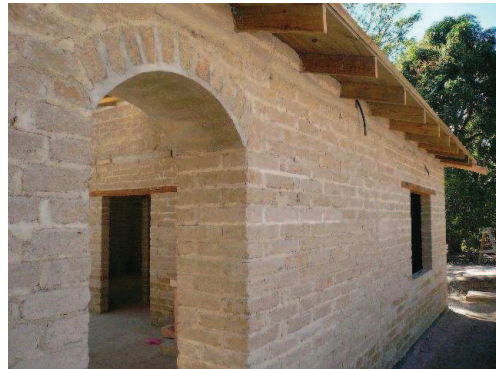
Ilustración 14. Vivienda construida con adobe. Fuente: Archivo propio Fecha: 3/10/2012
