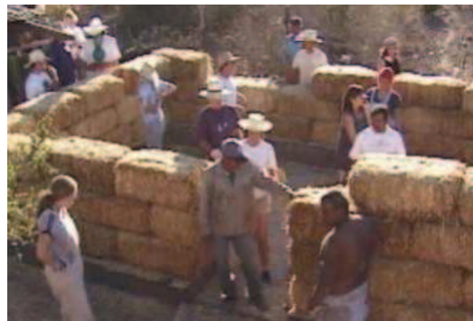
Ilustración 15. Vivienda construida con pacas de paja. Fuente: Archivo Propio Fecha: 3/10/2012
