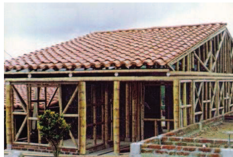
Ilustración 13. Uso de bambú en construcción. Fuente: Archivo Propio Fecha: 3/10/2012
