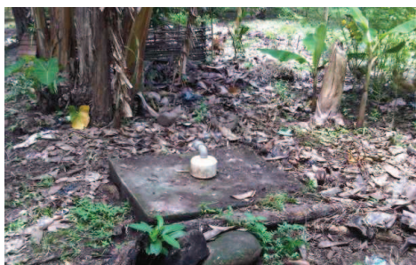
Fotografía 23. Pozo de Agua Potable Fuente: Archivo propio
