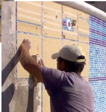
Foto no.156 mantenga la rejilla básica de diseño de piso o trazo recto y perpendicular Foto: Oscar López
