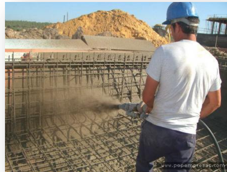
Foto No. 97 Mortero proyectado en vía húmeda, gunitado de piscinas Foto. Alicante popempresas
