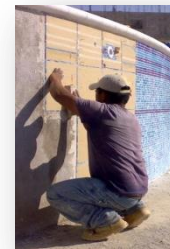
Foto No. 153 al tener el formato lleno y parejo, puede fijarse a la pared con el procedimiento adecuado. Foto: Oscar López
