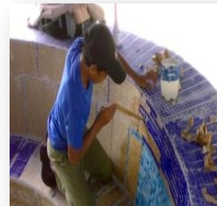
Foto no.157 mantenga la rejilla básica de su diseño o trazo recto y perpendicular posible Foto: Oscar López
