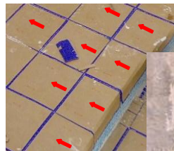
Foto no. 155 Alineación y asiento del mosaico con una pieza de madera o una plancha para asentar mosaico foto: Oscar López
