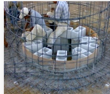
Foto No 119 Solera inferior y refuerzo horizontal de piso Foto No. 120 Solera inferior de elemento arquitectónico dentro de la piscina. Proyecto: Rodríguez Fotos: Oscar López
