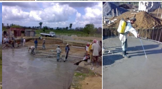
Foto No. 110 Día de fundición, material en obra Foto No. 111 Manipulación, carretillas de mano Foto No. 112 Fundición de piso y acarreo de concreto Foto No. 113 Vista panorámica de fundición días después foto No. 114 y 115 Aplicación producto para curado de piso. Proyecto, Rodríguez, playitas, Izabal Fotos: Oscar López
