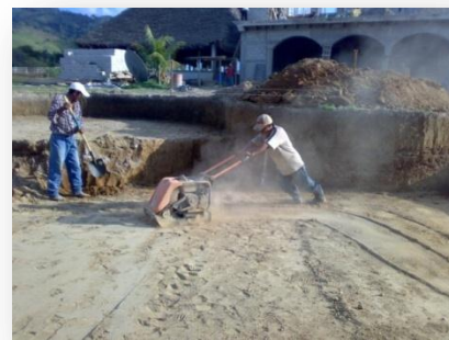
Foto No. 98 Corte de talud a mano para aplomado y compactación para evitar hundimientos
