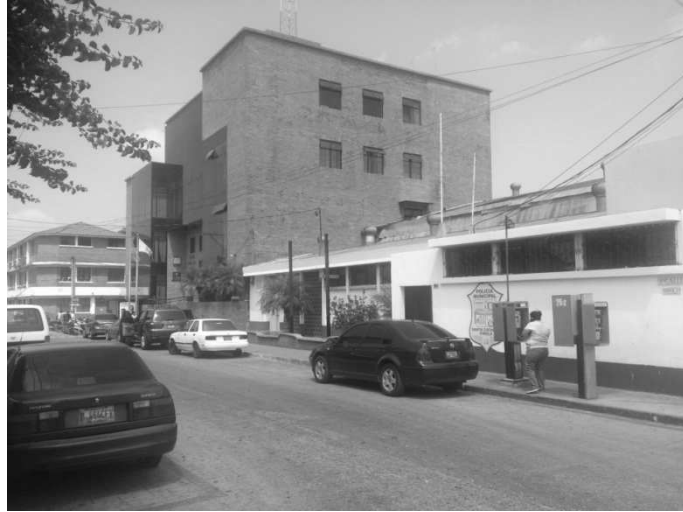
Imagen fachada a colindancia edificio Municipal
