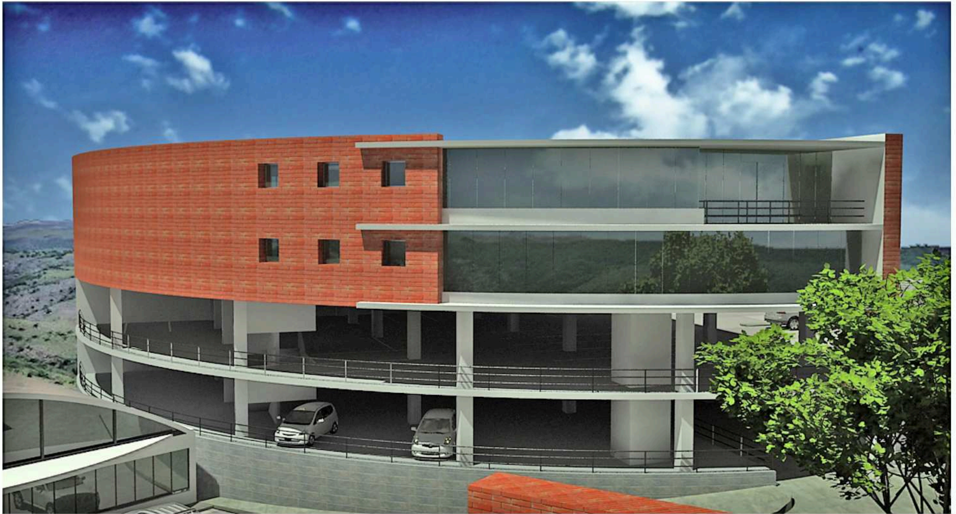
APUNTE FACHADA POSTERIOR EDIFICIO MUNICIPAL
