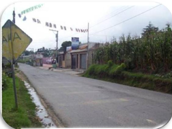
Carretera que conduce a los municipios de altiplano marquense (12N) está hecha en base de asfalto con un rodamiento de 6m., cuenta con una sola cuneta para movilizar las aguas pluviales.
