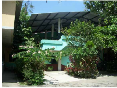
Fotografía 6: Vista de la circulación vertical, hacia el salón de usos múltiples en el 2do nivel y los dormitorios, estas tienen un ancho de 0.90 mts. y presentan problemas en la circulación.
