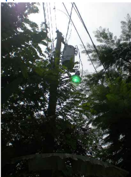
Fotografía B: Energía Eléctrica. Existe un Transformador de 75KVA, a 20 metros de la Estación 1, el cual servirá para suministrar al nuevo proyecto del servicio eléctrico.
