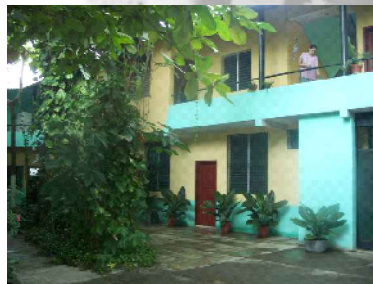
Fotografía 10: Los ambientes para atender al migrante y el área de dormitorio del director se encuentran muy cercanas y presentan cruce en las circulaciones, mezclando así las áreas públicas y privadas.
