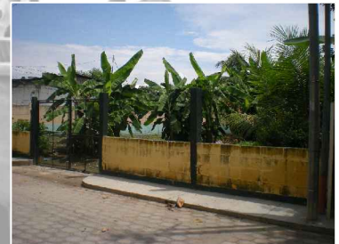
Fotografía E: El terreno asignado cuenta con un muro perimetral del block y malla, el cual se conservará.
