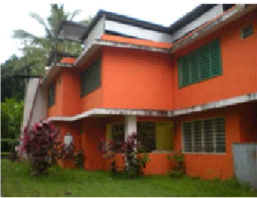
Fotografía 9: El diseño de la ampliación fue realizado con conceptos de sustracción de cubos y unión de formas circulares y cuadradas, lo que hace el diseño interesante y con movimiento, también cuenta con iluminación y ventilación natural.
