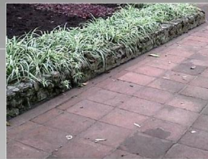
Fotografía 51: Caminamientos de Baldosas de Barro Cocido en el centro del Bulevar principal.
