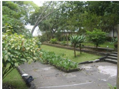
Fotografía 43: Caminamientos y bordillos de concreto fundido.
