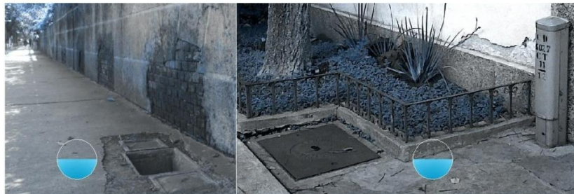
Fotografías 24 y 25: Acometidas de Agua potable del Jardín Botánico sobre avenida La Reforma y 1ra. Calle Guatemala. Fuente: Fernando Lux, 2011.
