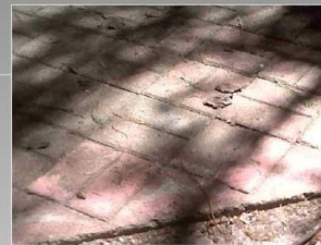
Fotografía 52: Caminamientos de Baldoquin de Concreto.
