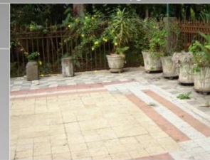
Fotografía 53: Piso Modular de Cemento Liquido y combinación de estampado variado en patio del CECON.
