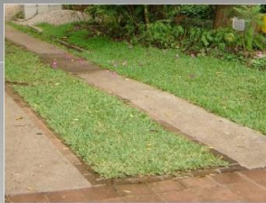
Fotografía 50: Losas de Concreto Fundido sobre el Bulevar principal.
