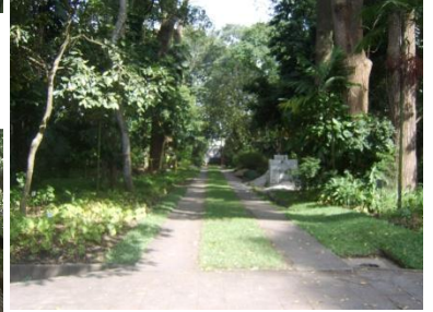
Fotografía 37: Carrileras de concreto fundido del ingreso por la 2da. Avenida zona 10.
