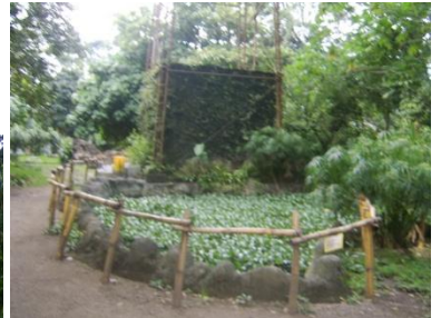
Fotografía 33: Estanque requiere equipo de bombeo para la circulación de líquido estancada. Al fondo estructura metálica.
