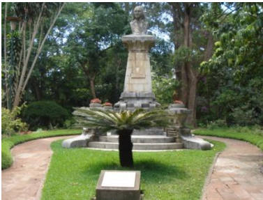
Fotografía 42: Escultura de Linneo en el Centro del Jardín Botánico. Se observa el deterioro de las baldosas de barro en el caminamiento.
