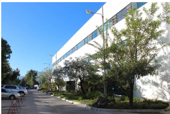
Postes de iluminación en el exterior de Unicar.
