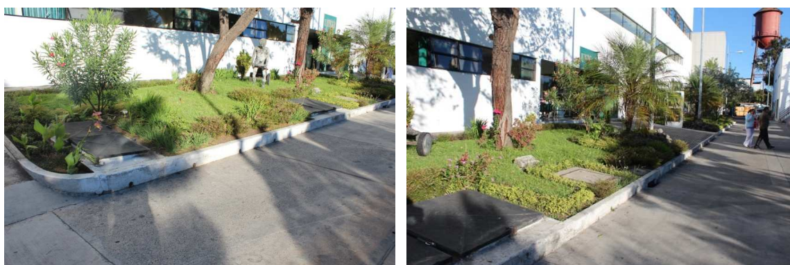
Las cisternas se encuentran ubicadas bajo el jardín que se encuentra enfrente de Unicar.
