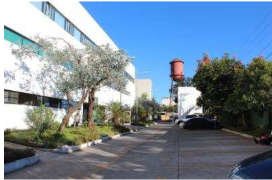
Vista de parqueo y edificio UNICAR
