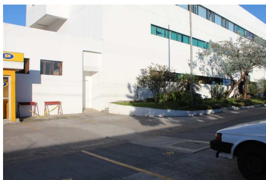
Las cajas de registro de drenaje se encuentran ubicadas en el parqueo
