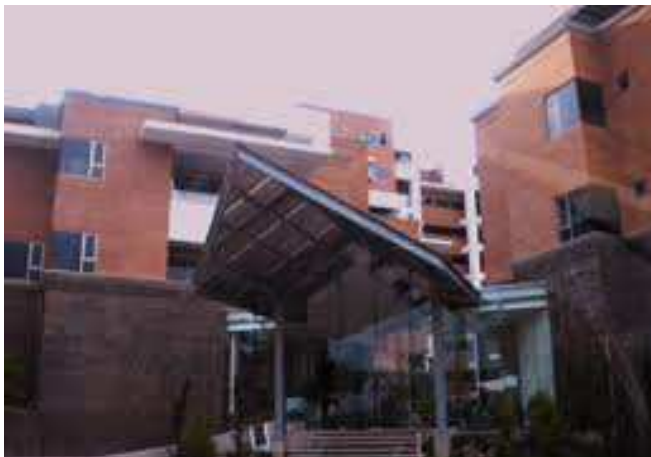
Imagen 11, fachada principal http://www.inversen.net/
