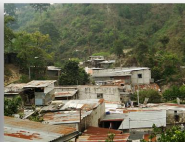
Viviendas ubicadas en el asentamiento Campo Seco.
