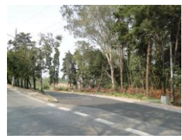
Boulevard Rafael Landívar, cuatro carriles, asfaltada, señalizado y con buena calidad de alumbrado público.
