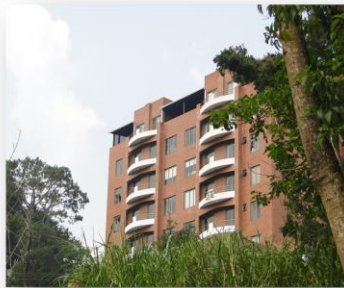
Residenciales La Montaña, edificación de 8 niveles, uso residencial.
