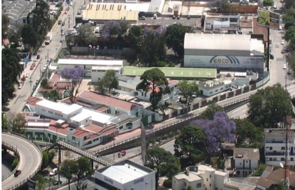
Vista aérea actual de edificio donde se encuentra la División de Mantenimiento y las Clínicas de Consulta Externa de "Autonomía"
