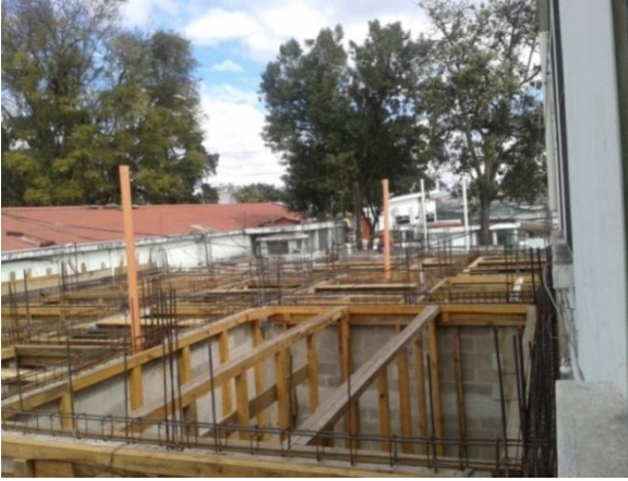
Vista actual del proyecto en construcción Clínicas de Cirugía Ambulatoria "Tecún Umán"
