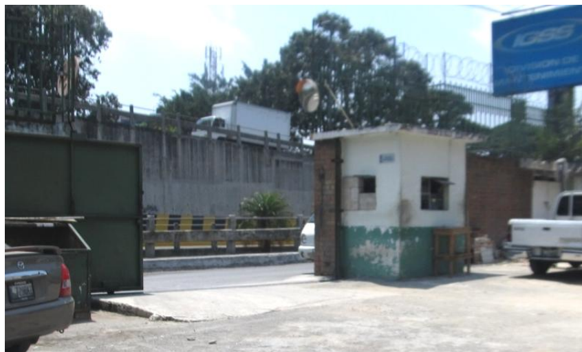
Vista actual de Ingreso y Garita de Control de Ingreso
