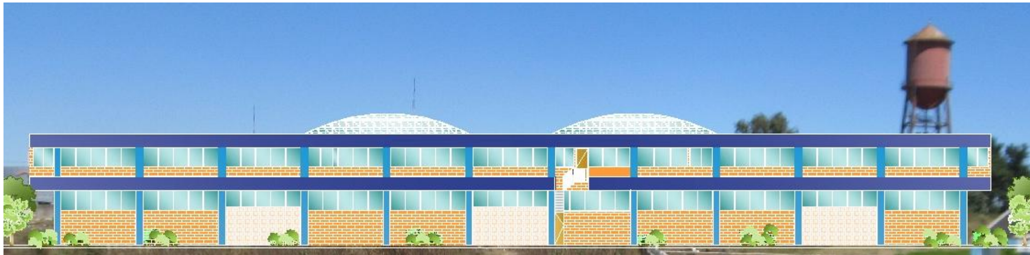
FACHADA POSTERIOR (SUR-ESTE)
