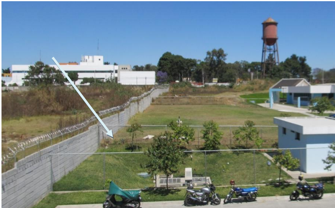
Vista del área donde actualmente se encuentra la planta de tratamiento de aguas negras de la Unidad Periférica zona 11
