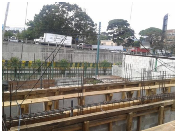
Vista actual del proyecto en construcción Clínicas de Cirugía Ambulatoria “Tecún Umán
