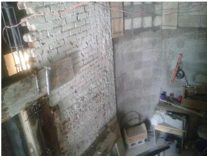
Vista actual de cerramiento entre la División de Mantenimiento y Clínicas de
