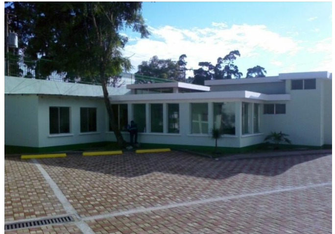
Vista actual del parqueo de personal de las Clínicas de Consulta Externa “La Autonomía”
