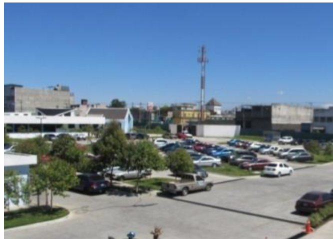
Vista de Clínicas pediátricas Joyabaj, UPZ11 IGSS Ingreso por 5ª avenida, zona 11
