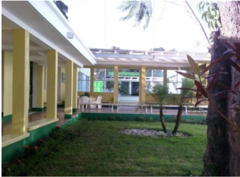
Vista actual de Pasillos de Consulta Externa “Autonomía”
