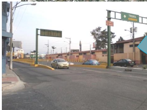
Ingreso 13 calle, viaducto zona 12
