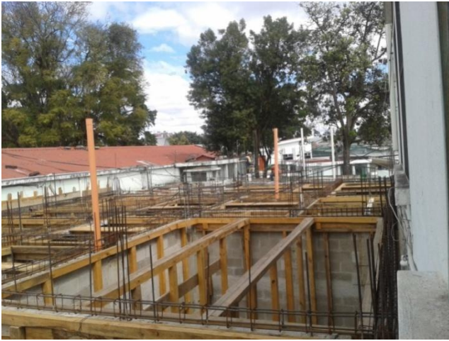
Vista actual del al proyecto de Clínicas de Cirugía Ambulatoria “Tecún Umán”, en el mismo terreno de la División de Mantenimiento
