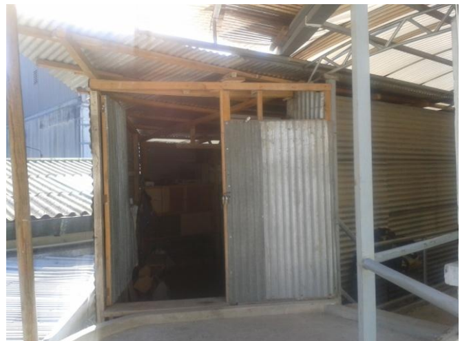
Vista actual de la bodega de inventarios DM y bodega del proyecto Clínicas de Cirugía Ambulatoria “Tecún Umán”
