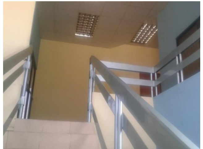
Vista actual de acceso al segundo nivel, área remodelada para Personal administrativo, técnico profesional de la División de Mantenimiento
