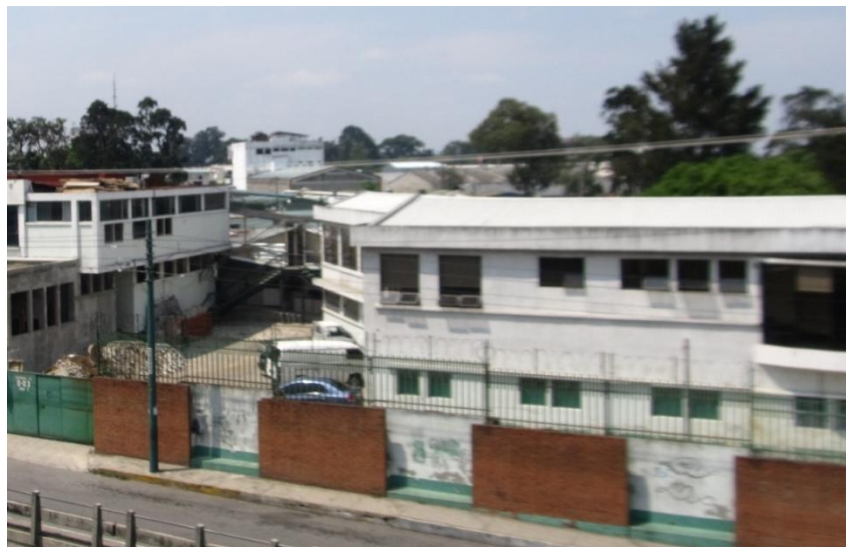
Vista Exterior de la División de Mantenimiento
