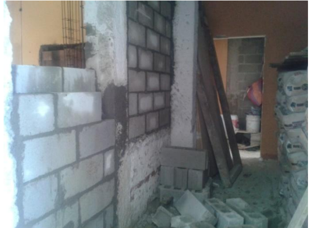
Vista actual de la colindancia del proyecto en construcción Clínicas de Cirugía Ambulatoria “Tecún Umán y las Instalaciones de la DM
