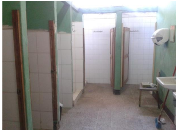
Vista actual de Servicios Sanitarios en el área de talleres de la División de Mantenimiento
