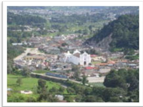
Imagen 61 V-1 (vista desde carretera interamericana) Fuente Personal
