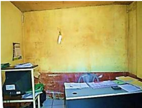
1. Se observa demasiada humedad en la oficina, grietas severas en el marco estructural además de fisuras en la pared.
