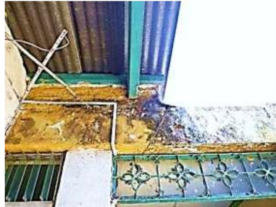
2. Daños en las estructuras metálicas de la cubierta en donde se observa que las instalaciones pluviales se encuentran al descubierto, mismas que podrían sufrir daños, provocando humedad en paredes.
