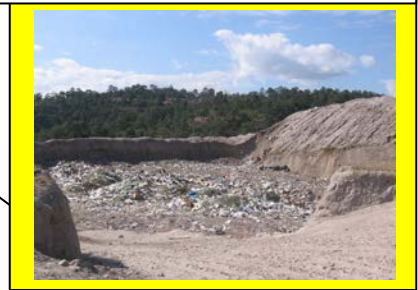
Foto 5. Se ve la fosa no. 6 que se empieza a llenar, esta fosa mide de 30*35*15, lleva todo tipo de materiales
