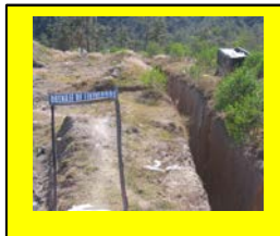
Foto 6. Vemos el agujero para el drenaje de lixidiados, y la letrina que lleva sus desechos a la misma tubería
