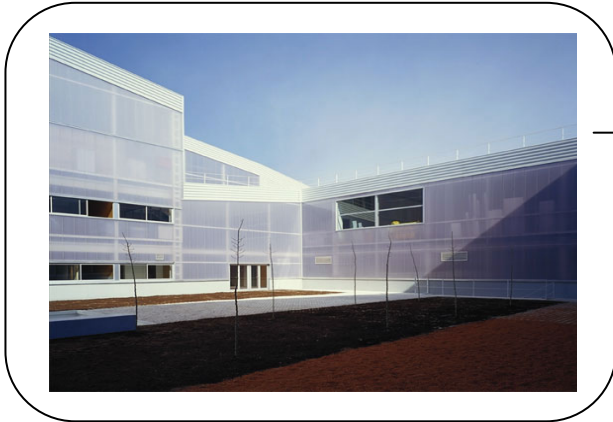
Foto 7. Se observa la estructura exterior y su fachada de materiales sencillos al igual que sus colores, mantienen la estética conforme al paisaje y su carácter efímero, teniendo la idea de transporte, montaje y cambio que sean de manera sencilla y rápida
