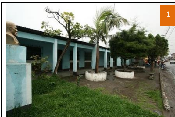
Fotografía 1. Estado Actual, fachada principal, Municipalidad de San Juan Alotenango, Sacatepéquez.
