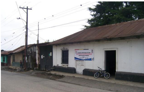
Fotografía 6. VIVIENDA TÍPICA. SAN JUAN ALOTENANGO. Imagen propia.
