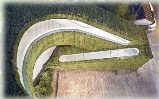
Foto # 3 Proyecto de MASS STUDIES Fotografía aérea del espacio exterior del edificio.
