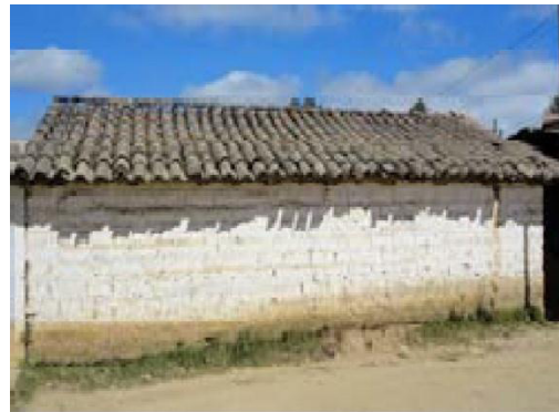
Fotografía No. 43 Vivienda ubicada la periferia del municipio (Zona 3), la cual se conserva en su totalidad intacta, y ya son de las pocas viviendas que no han sufrido ningún cambio. Captura Propia
