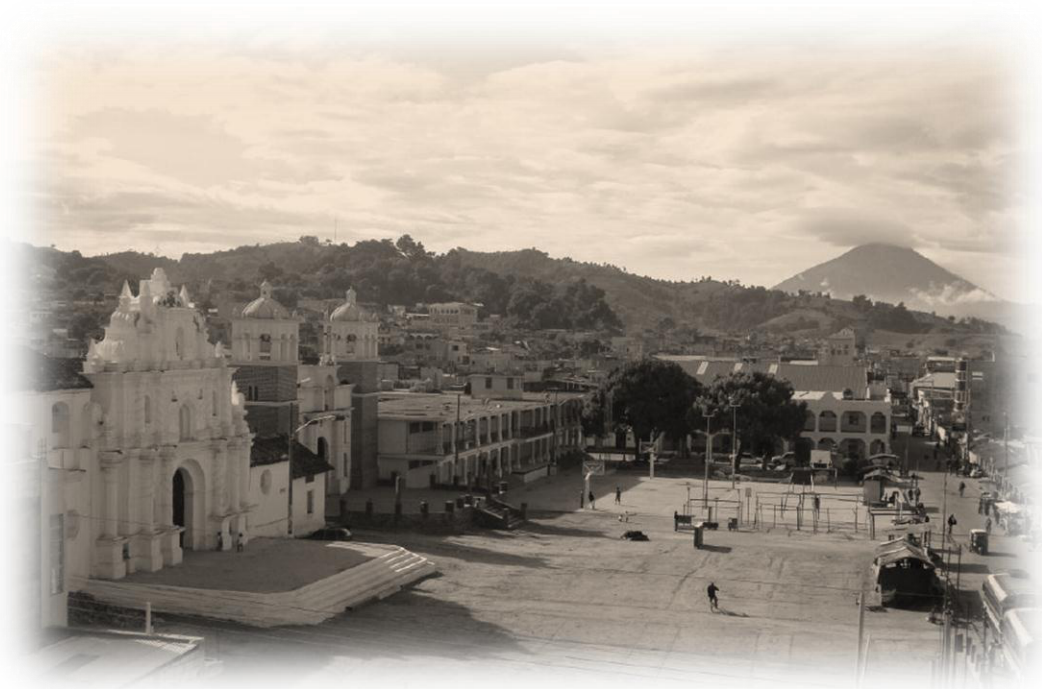
Vista Panorámica del Municipal de San Juan Comalapa. En la actualidad
