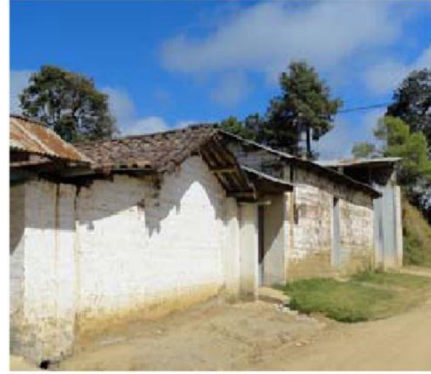
Fotografía No. 41 Vivienda ubicada en la periferia del municipio (Zona 4), la cual ya sufrió cambios en su arquitectura ya que parte de su techo esta con lámina de zinc y no con teja. Captura Propia
