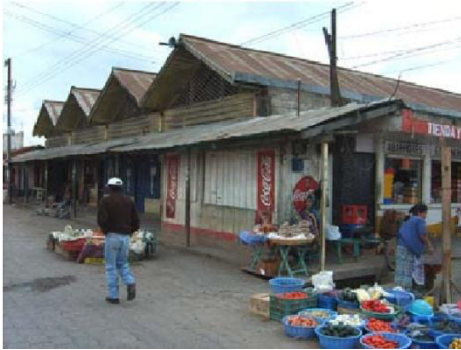
Fotografía No. 47 Mercado Municipal, ubicado en la parte central del municipio (zona 4). Fotografía tomada en el año 2009. Fuente: Omar Bal.
