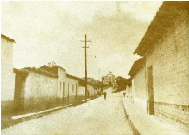
Fotografía No. 59, Imagen de la calle del ingreso al municipio, viviendas tradicionales construidas con adobe y techos de teja. Fotografía proporcionada por Edgar Catú, tomada 1975
