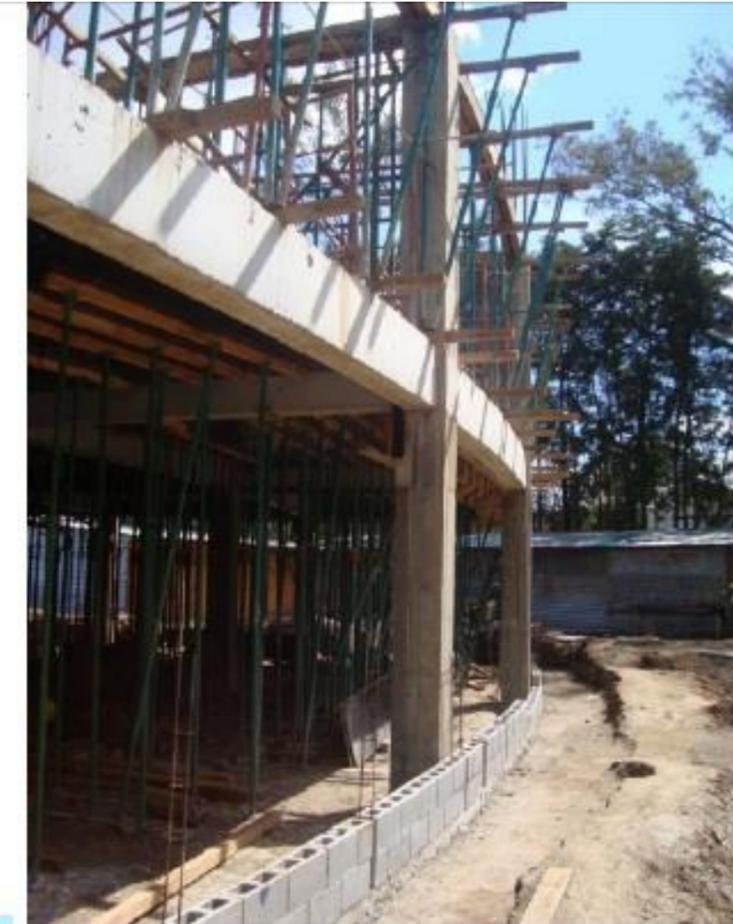
Las losas serán con el método de vigueta y bovedilla para reducir el gasto de concreto y con ello la contaminación generada por la arena, piedrín y cemento
