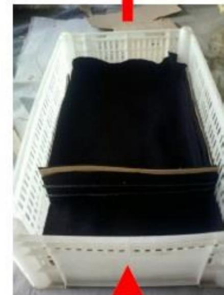
Para evitar el paso de raíces se protege con una capa de fieltro o geotextil
