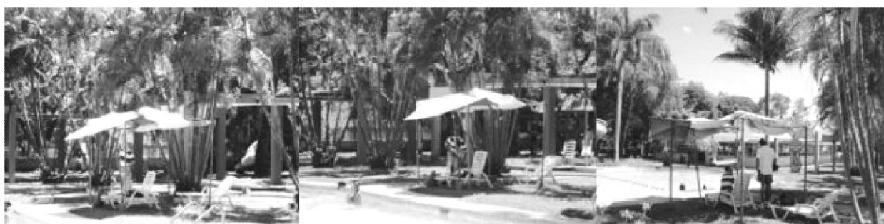
Puesto de vigilancia, fabricado con tubos de acero galvanizado, instalado en el centro recreativo Las Ninfas, Amatlán. Fuente: Antonio Pérez.
