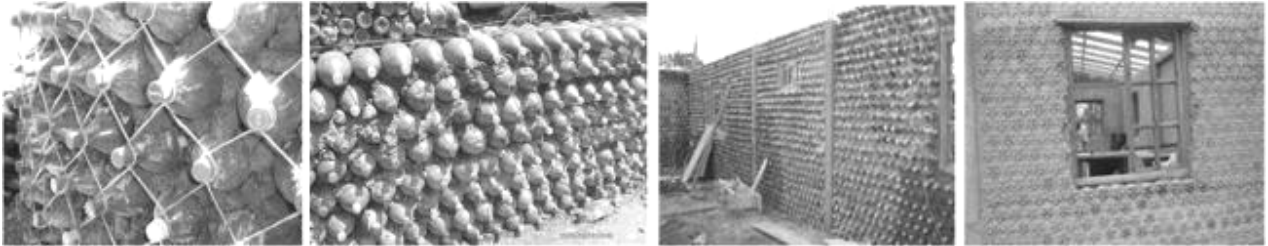
Uso de envases PET en la construcción de muros. Fuente: www.basurilla.org , Construcción de Casas con Botellas en México.
