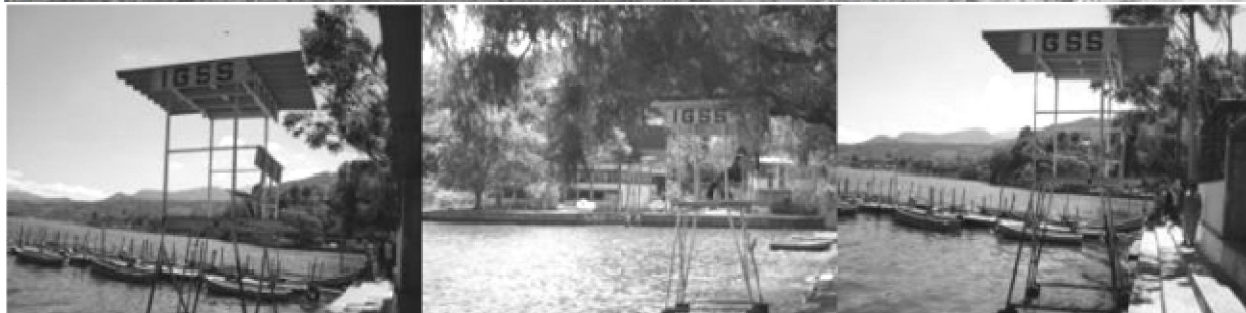
Torre de vigilancia típica, fabricada con tubos de acero galvanizado, instalada en la playa de Amatlán. Fuente: Antonio Pérez.
