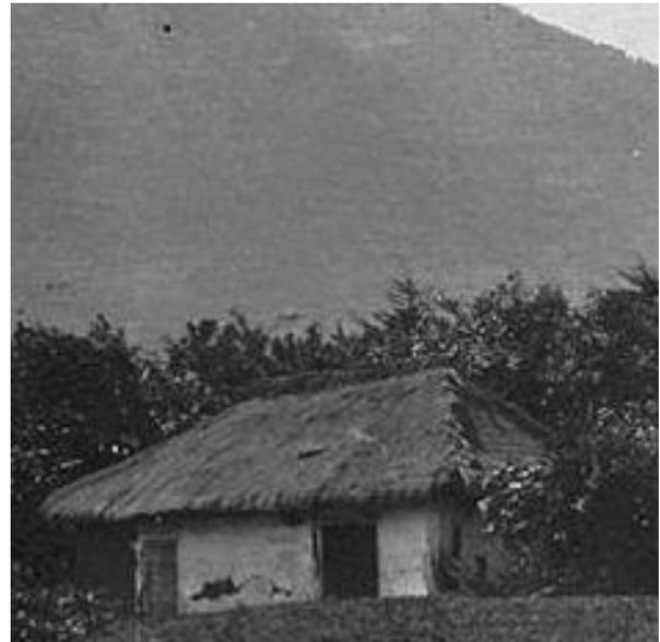
*ELEMENTOS CONSTRUCTIVOS DEARQUITECTURA VERNÁCULA RURAL: MUROS DE ADOBE, PILARES DE MADERA, ESTRUCTURA DE TECHO MADERA LOCAL RUSTICA, TECHOS DE BARRO COCIDO ARTESANAL, TECHO PAJÓN.*
