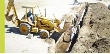
Trabajando en el drenaje de la nueva propiedad.
