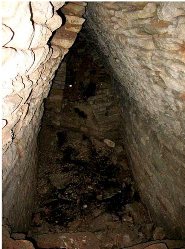
Fotografía mostrando el sistema constructivo del falso arco Maya, utilizado en los pasillos del Palacio Real.
