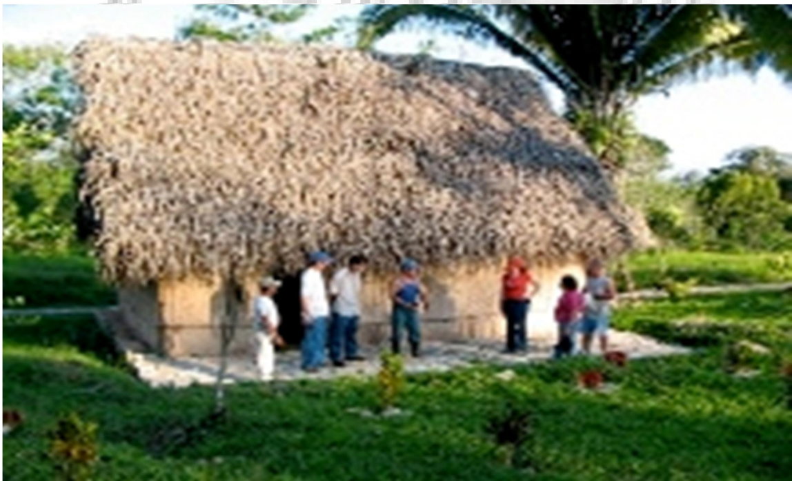
Vista de la infraestructura que existe en Cancuen.
