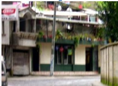
Fotografía 14. Viviendas Existentes en el Sitio. Fuente: Autor. Agosto de 2012
