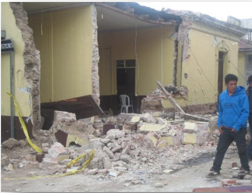
Fotografía. Terremoto 7 de Noviembre, San Marcos, Fuente Autor. Diciembre de 2012
