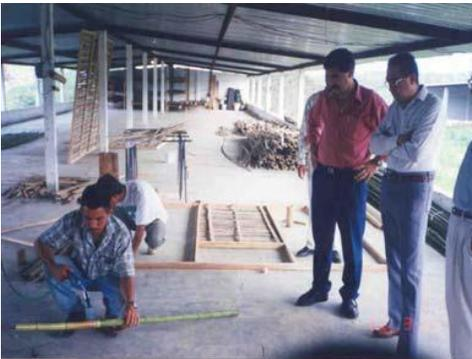
**Fotografía No. 16 Armado de panel de Bambú**
