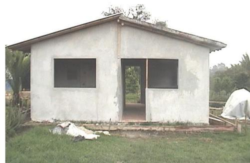
**Fotografía No. 47 Paredes exteriores revocadas**
