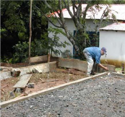
**Fotografía No. 26 Nivelación con capa de material de cantera para colar el piso**
