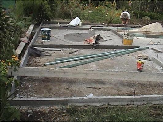
**Fotografía No. 25 Proceso de construcción del cimiento**
