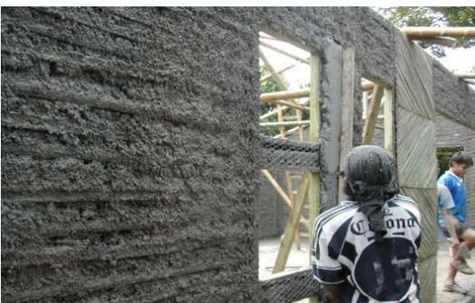
**Fotografía No. 43 zarpeado de paneles utilizando arena y cemento con la finalidad de que se adhiera la mezcla para el revoco.**
