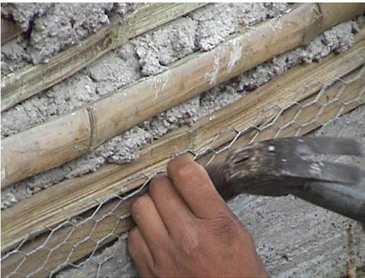
**Fotografía No. 42 Colocación de tela gallinera en los marcos de madera en esquinas, perfiles de las puertas y ventanas para la adherencia del cemento**
