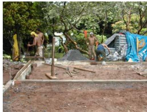
**Fotografía No.23 y 24 Colado de Cimentación y Cimentación Terminada**
