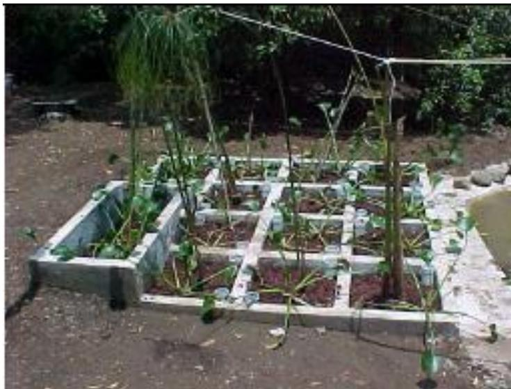
Fotografía No. 49 Una vez terminada las cajas se llenan con grava hasta el nivel de salida del agua y se siembran plantas acuáticas (papiro, carrizo, tifa, lirio acuático)
