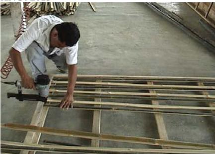
**Fotografía No. 17 Armado de panel con Máquina Industrial**
