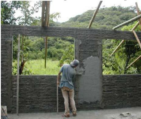
**Fotografía No. 44 Revocado de paneles de revoco para la**
