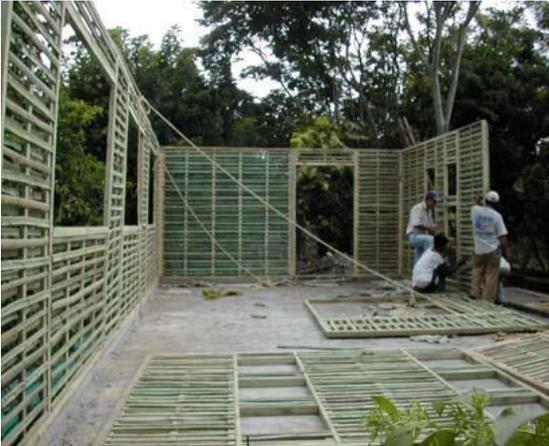
**Fotografía No. 28** Piso colado antes de colocar los paneles
