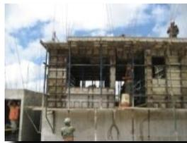
Meta consistente en la construcción de gradas del primero al segundo nivel y la construcción de los muros y losa de techo con toda su estructura de acero y con las instalaciones de plomería, instalaciones eléctricas y especiales.
