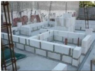
El sistema constructivo en la construcción de viviendas más conocido y el más utilizado hasta hoy, ha sido el de las viviendas con muros de mampostería o block reforzado con columnas y soleras. Este es un sistema que se utiliza mucho en la construcción de viviendas no en serie (atípicas) y muy poco en la construcción en serie (casas típicas). La razón de que ya no se está usando
