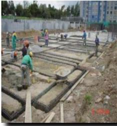
Posterior al relleno del zanjeo de las tuberías de las instalaciones bajo suelo, procedemos a la excavación de los cimientos, colocación de la armadura de los cimientos y la losa de cimentación, dejando los refuerzos verticales de los muros, así como las mangas de todas las instalaciones, para finalmente proceder con la fundición.
