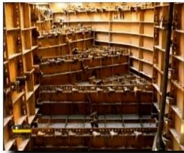
Las actividades secuenciales son armadura muros, colocación tuberías de plomería – electricidad - especiales, colocación formaleta muros y losa, colocación armadura de losa, fundición de muros y losa monolíticamente; paralelamente se estaría formaleteando las gradas, colocación armadura de gradas y fundición de gradas.
