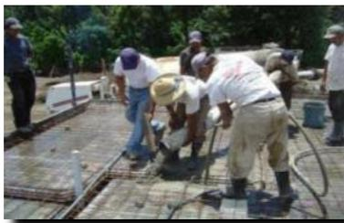
Consiste en la construcción de los muros del primer nivel, junto con la losa de entepiso con toda su estructura de acero y con las instalaciones de plomería, instalaciones eléctricas y especiales. Las actividades secuenciales son armadura muros, colocación tuberías de plomería-electricidad-especiales, colocación formaleta muros y losa, colocación armadura de losa, fundición de muros y losa monóticamente.
