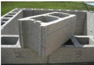
Las unidades pueden ser macizas, de perforación vertical y de perforación horizontal. Las unidades de perforación vertical son las más utilizadas, ya que permiten la colocación de barras de refuerzo a través de ellas, las cuales son fijadas al muro mediante mortero de relleno (grout). Las unidades pueden ser de arcilla cocida, de concreto y de sílice-cal; para este estudio usaremos la unidad de
