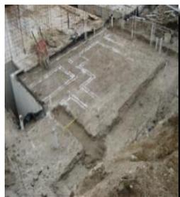
La meta 1 en el proceso de la construcción con formaleta de aluminio consiste en la etapa posterior a la conformación de plataformas perfectamente niveladas, en la cual se traza, se excavan y rellenan las zanjas donde se colocan todas las instalaciones bajo el suelo, tanto las instalaciones hidráulicas y sanitarias, como las instalaciones eléctricas y especiales.
