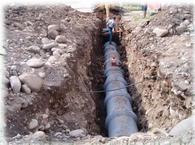
Ilustración 46 Fuente: Prensa Libre.com/ Introducción de drenaje sanitario
