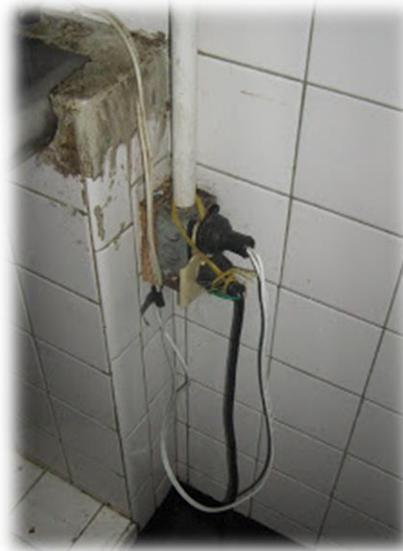
Ilustración 10 Fuente: Prensa libre.com/ instalaciones eléctricas en mal estado H. J.J. Ortega
