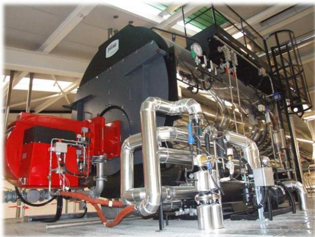
Ilustración 26 fuente: [thermal-oil-boilers.com/](http://thermal-oil-boilers.com/) caldera de vapor industrial
