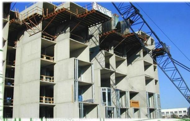
Ilustración 38 Fuente: [www.civil.cicloid.es.com/](http://www.civil.cicloid.es.com/) Muros portantes.
