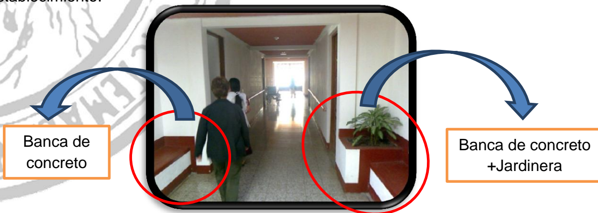
Fotografía No.21 Fuente Propia Ingreso Principal de las Instalaciones marzo de 2013
