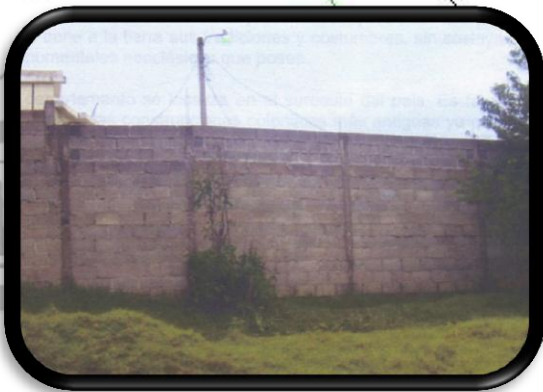
Fotografía No.55 Fuente: Propia Ingreso 6ta. Calle Los Cerezos, Julio 2012
