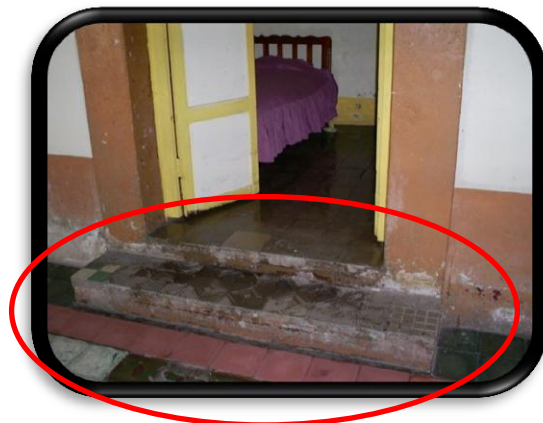
Fotografía No.16 Fuente Propia Ingreso a Dormitorio Febrero de 2013
