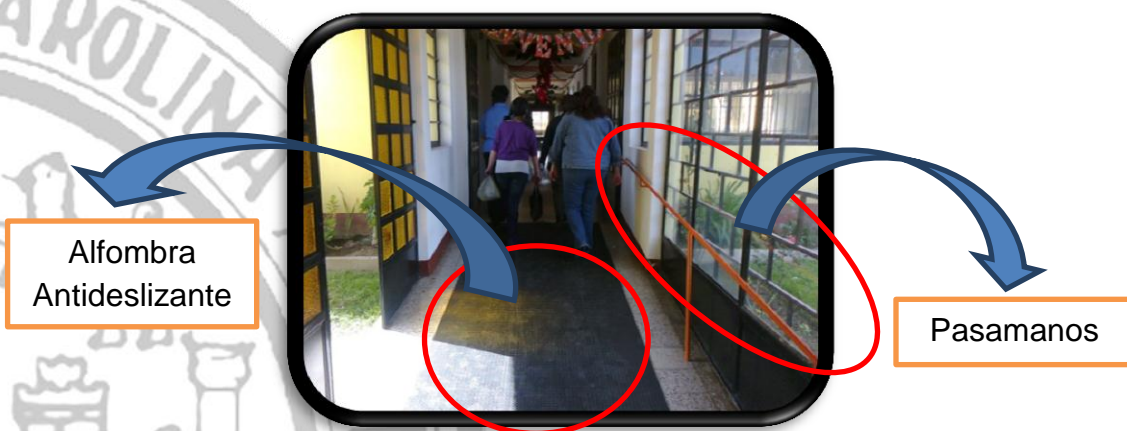
Fotografía No.20 Fuente Propia Ingreso Principal de las Instalaciones marzo de 2013
