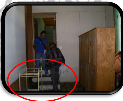
Fotografía No.15 Fuente Propia Ingreso a Dormitorio Febrero de 2013
