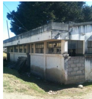
Imagen No. 7. Fachada principal Fuente: Elaboración propia.
