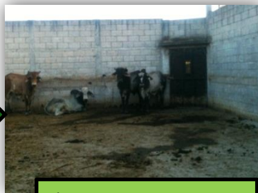
Área de corral esta no se encuentra completamente techada.
