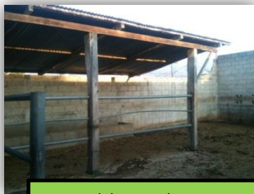
Area del corral que se encuentra techada, también sirve como área de protección.
