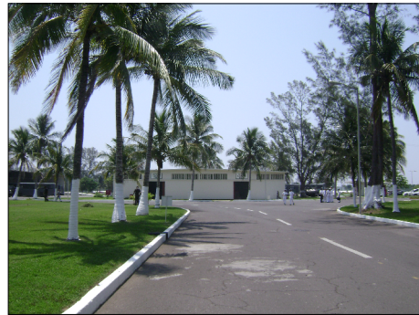
5 BODEGAS DE CUBIERTA Y ALBAÑILERIA
