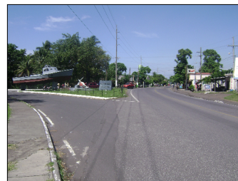
F-8 VISTA CA-9 HACIA PUERTO SAN JOSE
