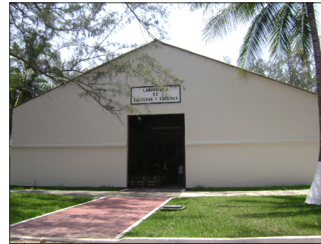
24 LABORATORIO CALDERAS Y TURBINAS
