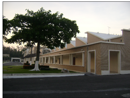
52 EDIFICIO DE MANTENIMIENTO DE INGENIERIA
