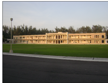
47 EDIFICIO AULAS Y BIBLIOTECA
