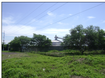
F-10 VISTA HACIA EL ESTE PLANTA CARBON MINERAL
