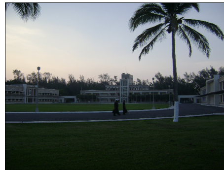
53 VISTA EDIFICIO ADMINISTRATIVO FRENTE AL CAMPO DE HONOR
