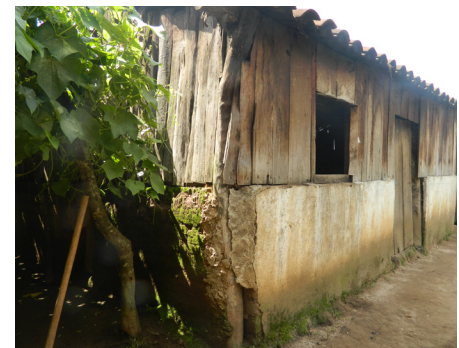
55. VISTA EXTERIOR DE LA COCINA
