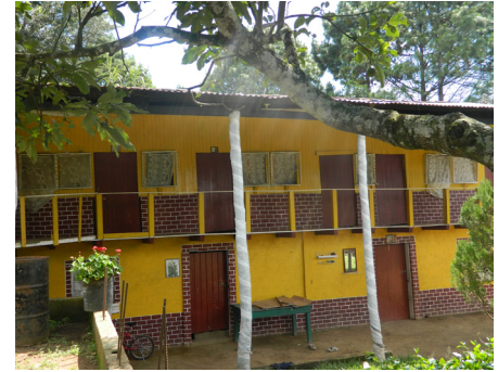
54. VISTA DE DORMITORIOS
