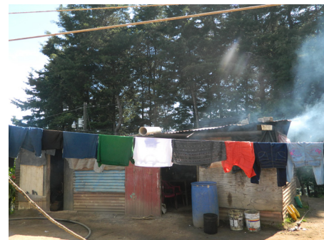
47. VISTA EXTERIOR DE LA COCINA
