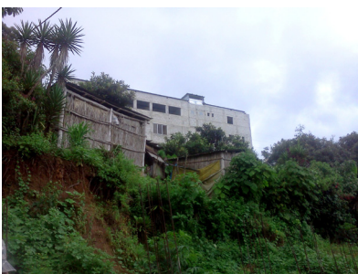
03. CONSTRUCCIÓN EN BARRANCOS
