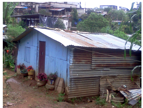
50. VISTA EXTERIOR DEL DORMITORIO
