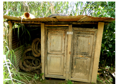
56. VISTA EXTERIOR DE LA LETRINA
