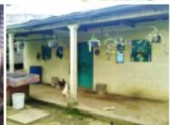
Fotografía No.28: Vista exterior del dormitorio principal. Fuente: Juan Arévalo.
