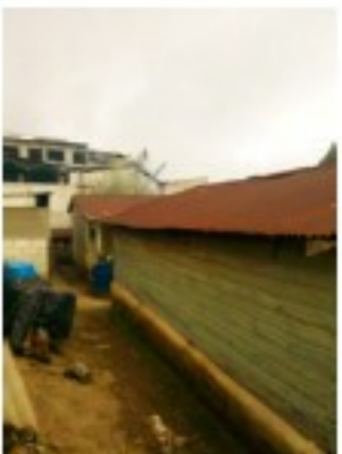
Fotografía No.24: Fachada exterior del taller de confección. Fuente: Juan Arévalo.
