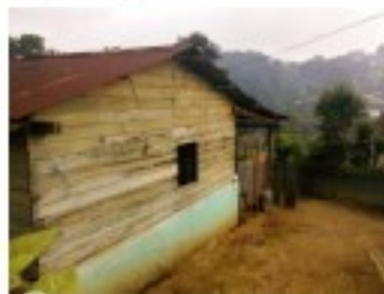
Fotografía No.26: Vista exterior de la cocina con lavadora, mostrador en madera y mesadas. Fuente: Juan Arévalo.
