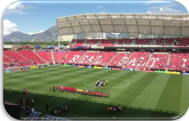
Fotografía No. 21 Vista Aérea Estadio Costa Rica
