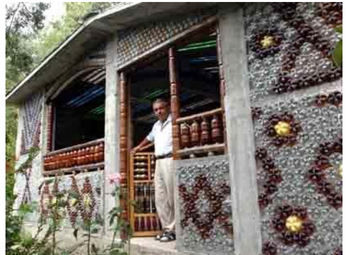
CONSTRUCCIÓN CON BOTELLAS PLÁSTICAS
