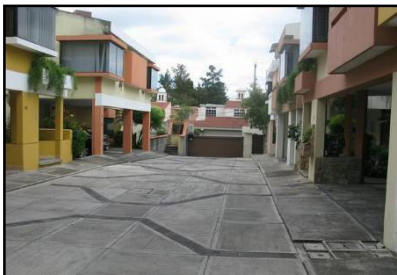
Vista interior 15 avenida v 45 calle
