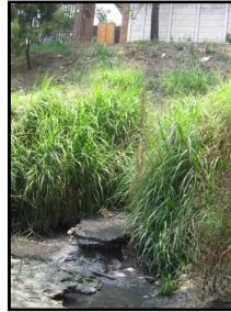
Drenajes de aguas negras y cabezal de descarga
