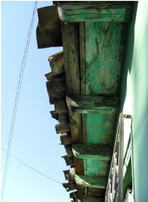
**Fotografía 126:** Aleros con vigas con detalles curvilíneos en los cortes, presentan cierto deterioro. Fuente: Mauricio Sosa
