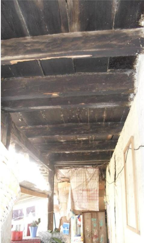
**Fotografía 84:** En estos inmuebles se accede por el lado del corredor, aunque en esta vivienda se modificó el acceso de la puerta, en la cubierta se observa el tapanco que por lo general se utilizaba para guardar utensilios. Fuente: Mauricio Sosa
