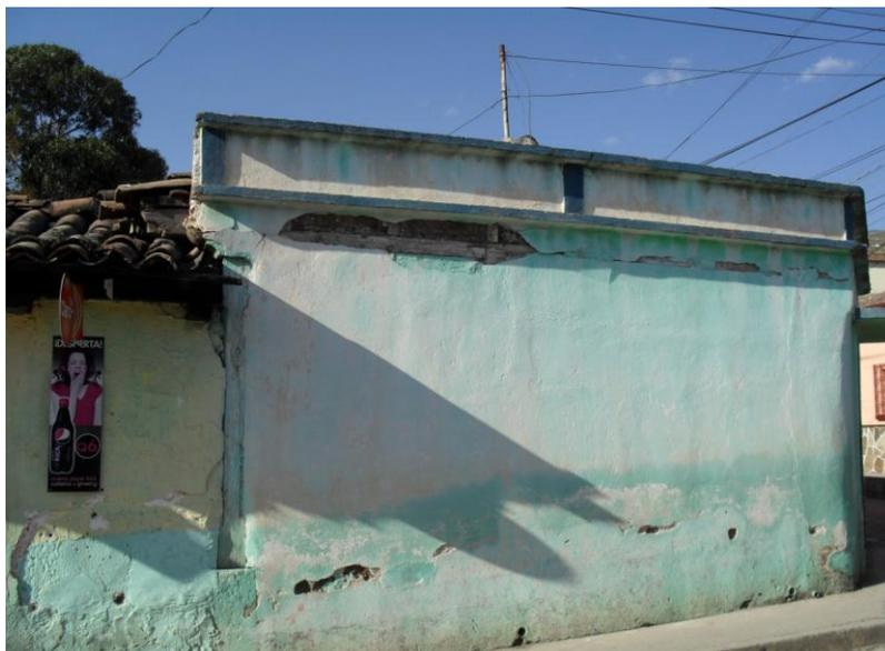
**Fotografía 165:** en apariencia estas dos viviendas son de la misma propiedad aunque por sus elementos de fachada y cubiertas les corresponde diferente tipología, también se observa en este inmueble en una parte de desprendimiento del repello la estructura de madera y adobe en la que está construida. Fuente: Mauricio Sosa
