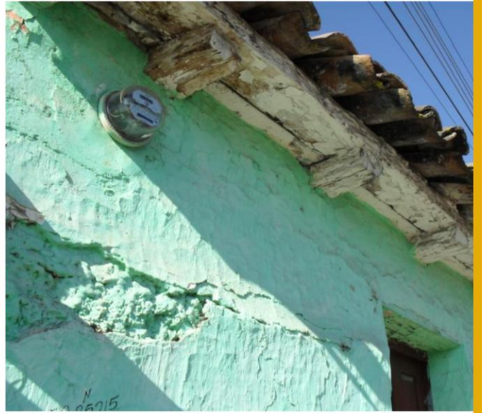
**Fotografía 178-179:** izquierda, se observa que estas viviendas se ataban las vigas de madera con los tendales con mecates, en donde los inmuebles más antiguos de la localidad conservan estos elementos. Derecha, en los aleros vigas de rectangulares y artesonado de madera de ciprés. Fuente: Mauricio sosa
