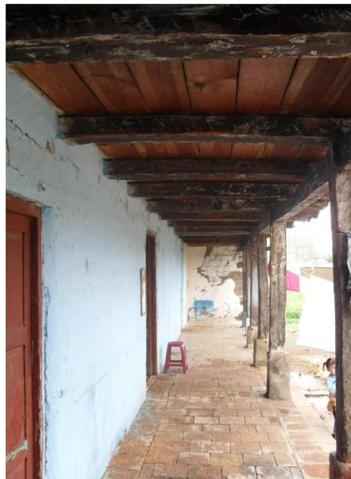
**Fotografías 190-191** Izquierda, en su interior es ampliamente apreciado el inmueble en donde se observa el tipo de adobe del cual es construido. Derecha, el corredor mantiene ese carácter tradicional con sus pilares de madera de ciprés, el tapanco característico y el piso de baldosa de barro. Fuente: Mauricio Sosa
