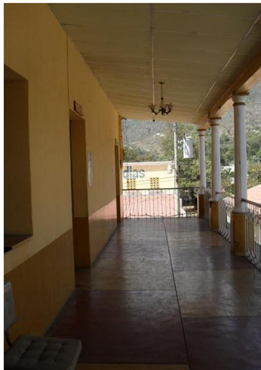
**Fotografías 55-56: Corredores:** El del primer nivel tuvo modificaciones en el entpiso que originalmente era de madera fue sustituido por concreto, a diferencia del segundo nivel que mantiene la cubierta original. Fuente: Mauricio Sosa.
