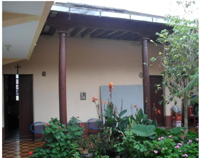
**Fotografías 101-102:** Izquierda, vista del segundo corredor. Derecha en ambos corredores se aprecia la integración de la cubierta de terraza española con el tallado de madera en vigas y columnas que es complementado en los ambientes con artesanado del mismo material. Fuente: Mauricio Sosa
