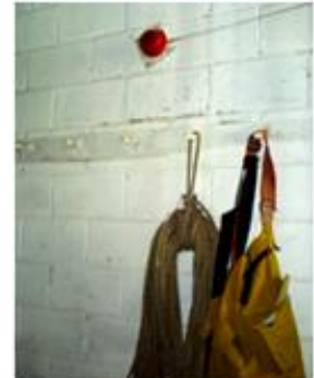
IMAGEN N. 17 Fuente Propia Area Equipamiento y Alarma
