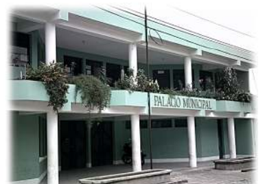
Arquitectura Estatal, San Rafael Las Flores
