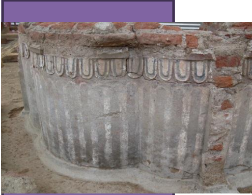
Ilustración 19Detalle de Fuente, ubicada en el patio sur del Claustro Central.
