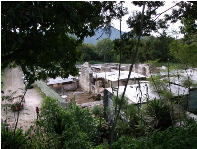
Ilustración 10 Vista del conjunto arquitectónico del Claustro Sur-Poniente.
