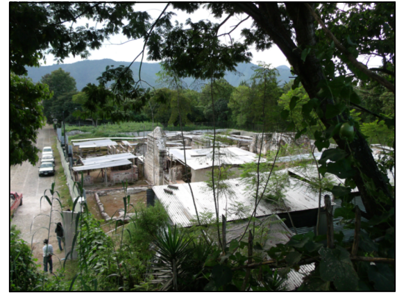
Vista desde el dique, al Este
