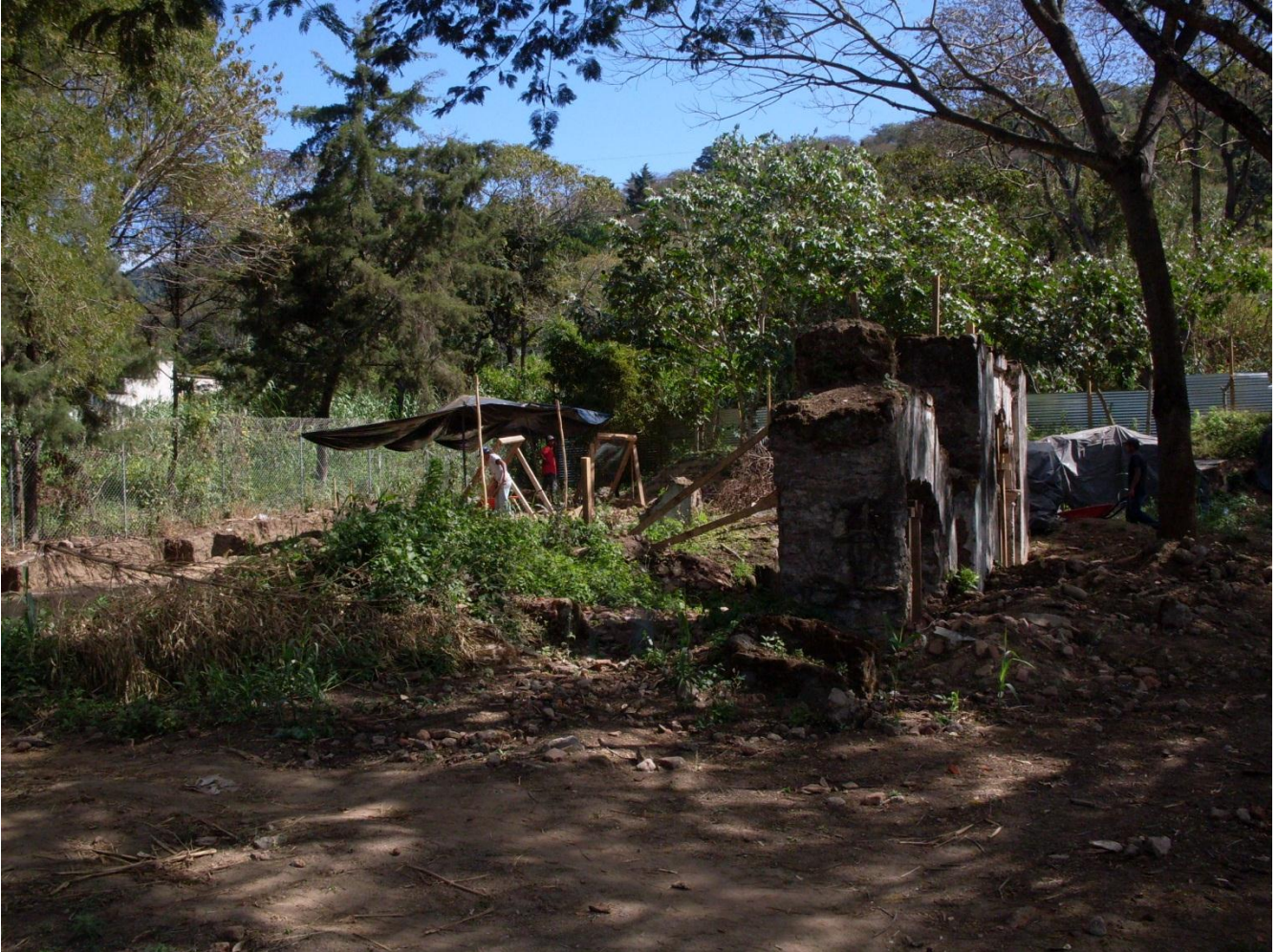
Área del proyecto previamente a la liberación de arena y ripio.
