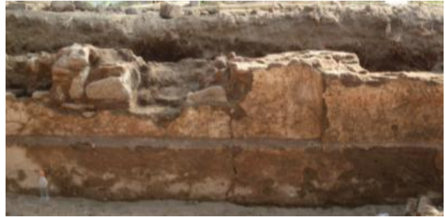
Ilustración 32 Desprendimiento de Estuco por humedad
