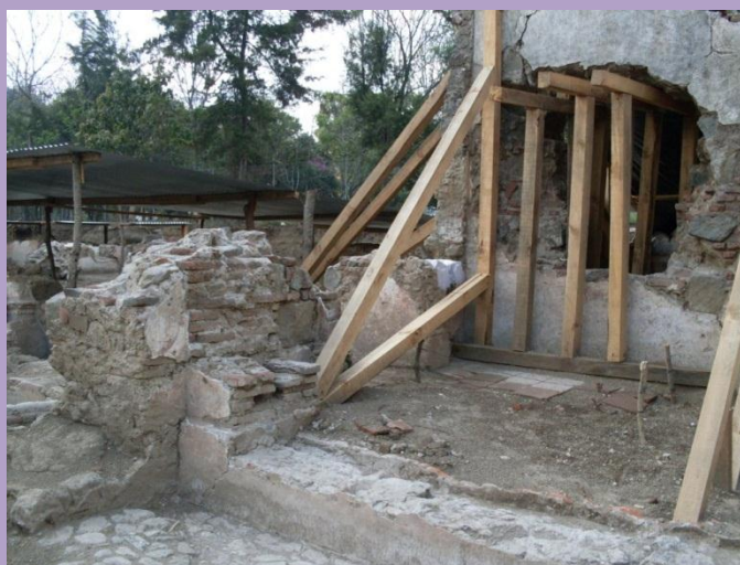
Ilustración 20 Detalle de técnicas de apuntalamiento.
