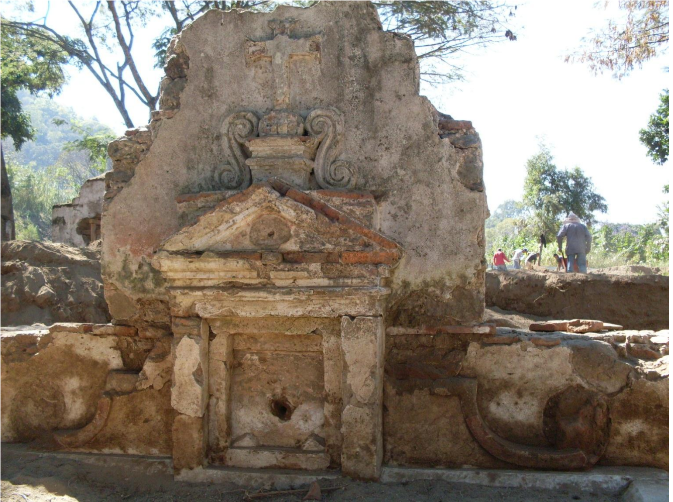
Detalle del nicho de la pila en el Claustro ubicado al Norte.
