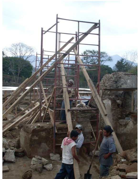
Ilustración 24 Proceso de remoción de escombros y apuntalamiento de muros, previo a retirar la arena.
