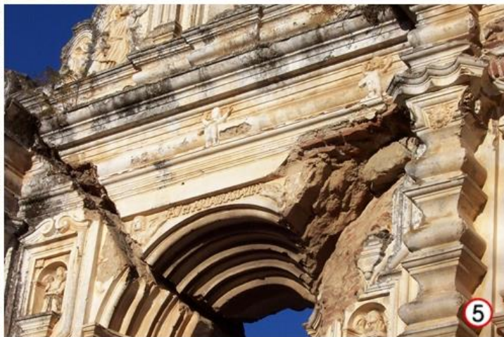
1) Endentado de grieta vertical 2) Integración de los arcos de corte 3) Integración de campanario 4) Integración de los arcos de corte 5) Consolidación de la fachada
