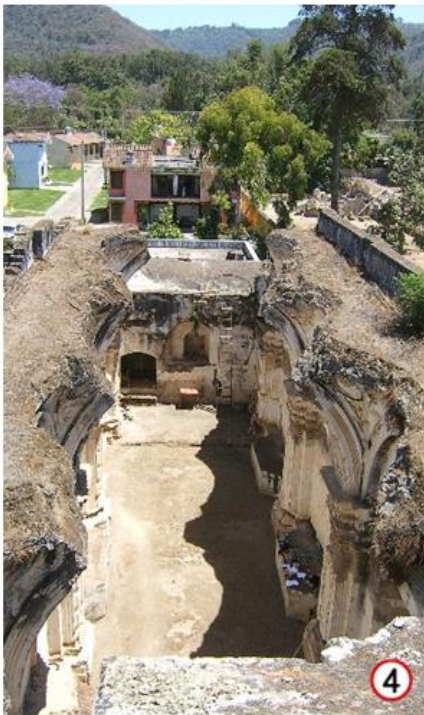
1) Endentado de grieta vertical 2) Integración de los arcos de corte 3) Integración de campanario 4) Integración de los arcos de corte 5) Consolidación de la fachada
