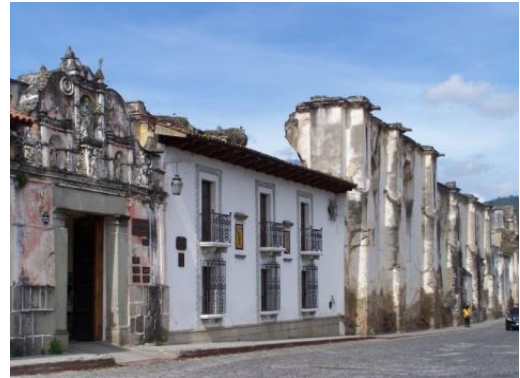
En los artículos 20 al 26, de la Ley Protectora de La Antigua Guatemala, se hace referencia al mantenimiento y protección de bienes inmuebles monumentales en propiedad privada
