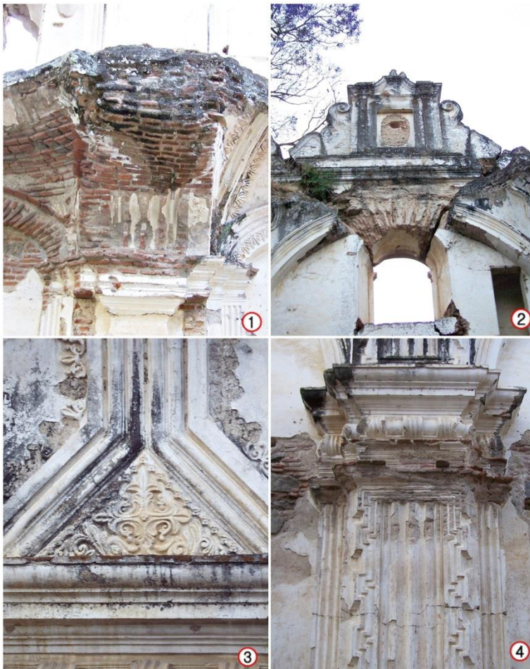
1) Arcos y bóvedas de mampostería (ladrillo) 2) Arcos de mampostería (ladrillo) 3) Acabado final y ornamentos con estuco y alisado a base de cal 4) Columnas de mampostería y muros de calicanto
