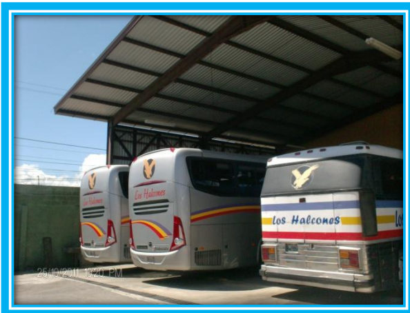
Fotografía No. 6: área techada para buses
