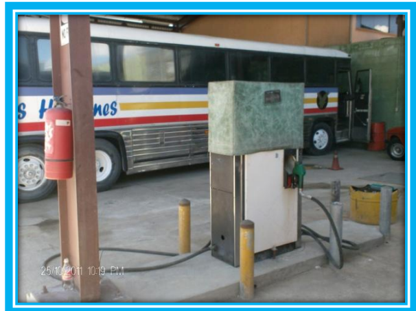
Fotografía No.7: tanque de combustible
