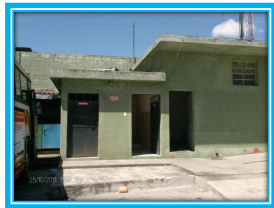
Fotografía 9: área de pilotos para descanso y aseo.
