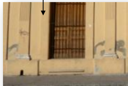
Integración de aplanados de distinto material
