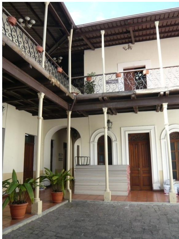
Detalle de los apoyos metálicos en los corredores de planta baja y planta alta de “La Casona”. Fuente: J. Cáceres, 2011.
