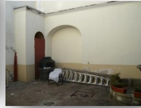
Arco tapiado que comunica los dos patios
