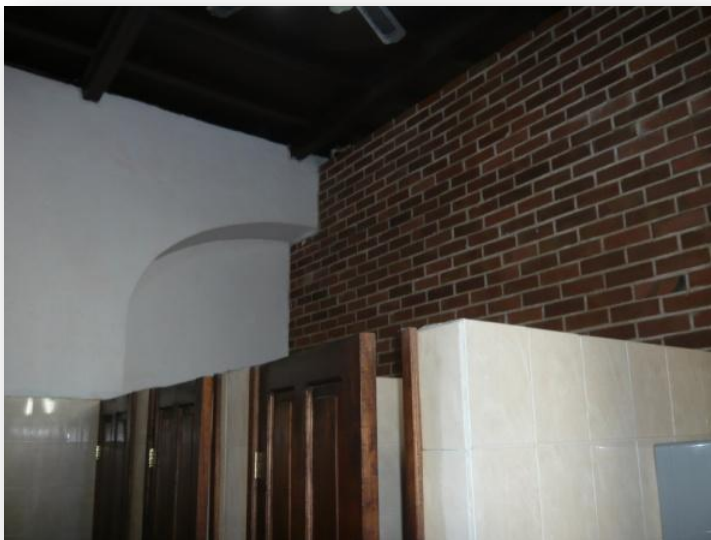
Disposición de tabiques para constituir baterías de baños. Nótese la división del arco y sobre posición de pisos.
