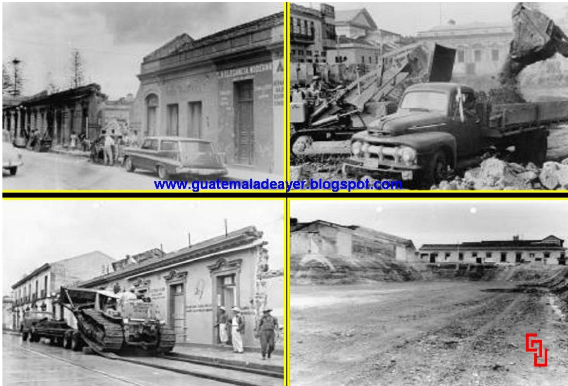
Fotografías de la demolición de las casas del predio frente a "La Casona" para hacer el Banco de Guatemala. Fuente: http://guatemaladeayer.blogspot.com/2011/05/historia-del-banco-central-de-guatemala.html . Consultada el 10 de julio del 2012.
