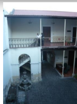
Vistas panorámicas del patio y el corredor en planta alta y planta baja. Denotando los apoyos de hierro sobre las bases de piedra.
