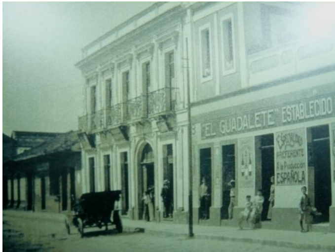
Detalle del uso original de la primera crujía.
