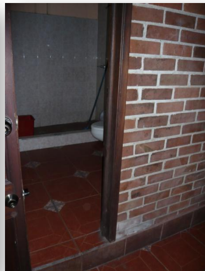
Disposición de tabiques para constituir baterías de baños. Nótese la división del arco y sobre posición de pisos.
