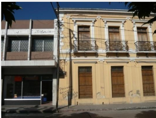
Detalle de la fachada y su colindancia Sur (Edificio Santa Cruz)
