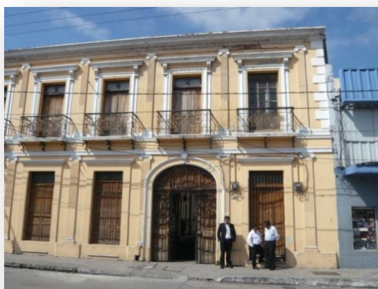
Detalle de la fachada y su colindancia Norte (Edificio De La Riva).
