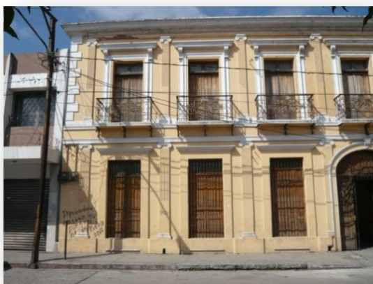
Detalle de la fachada en general.
