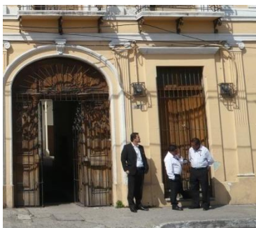
Contadores sobre la fachada.
