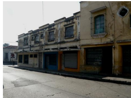
Detalle edificio esquina Suroeste, 11 calle y 9ª ave.
