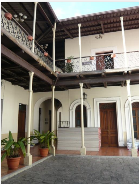
Vistas panorámicas del patio y el corredor en planta alta y planta baja. Denotando los apoyos de hierro sobre las bases de piedra.
