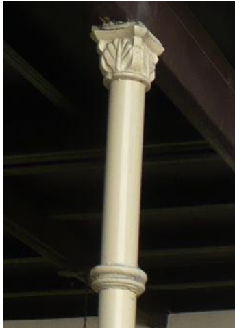
Detalle de los apoyos en hierro de “La Casona”. Fuente: J. Cáceres, 2011.
