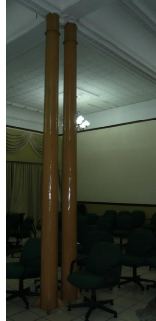
Apoys de hierro más grueso y sin decoración en los remates en la Casa Larrazábal.
