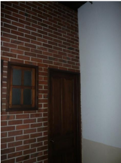
Muros de ladrillo no originales
