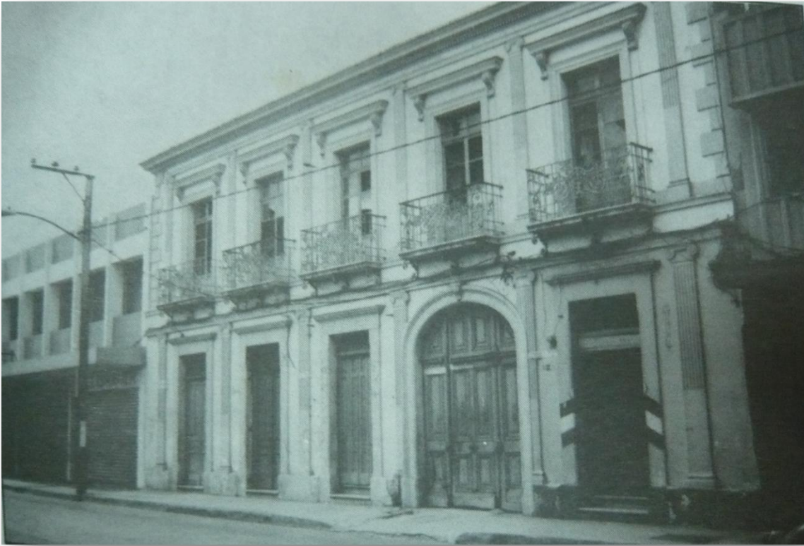
“La Casona”, denotando las puertas y la barbería. Fuente: Gaitán, 1995: 93.
