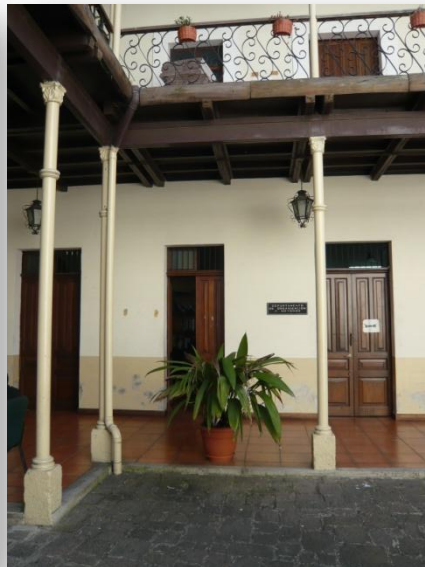
Detalle del corredor y el ritmo de vanos.
