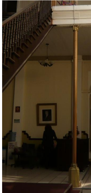
Detalle de los apoyos de hierro en Casa Larrazábal, (8ª Avenida entre 9ª y 10ª calle) Centro Histórico.
