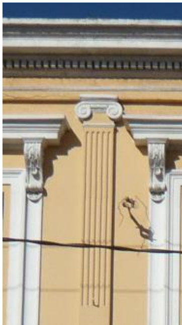
Detalles neoclásicos en la fachada de "La Casona".
