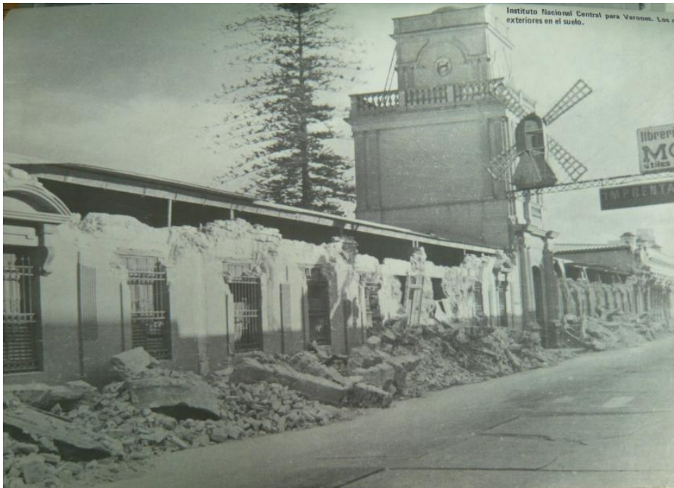
Muestra de las transformaciones humanas y naturales en el contexto de la 9ª avenida. Instituto Nacional Central para Varones en la 9ª avenida con los muros exteriores en el suelo por el terremoto de 1976. Fuente: Revista Cultural del Ejército, Año II, 1976.
