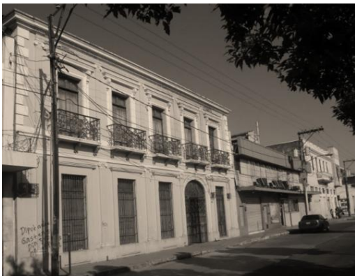
Detalle de La Casona. Fuente: J. Cáceres, 2012.
