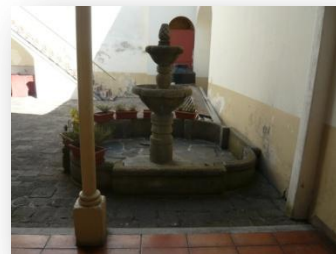
Fuente de concreto en patio 2
