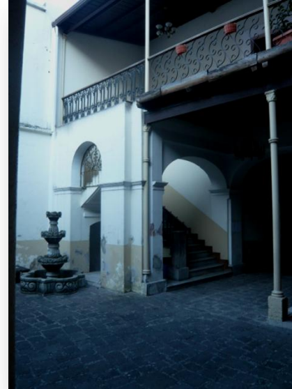
Detalle del módulo de las gradas principales, dispuesto a la derecha del acceso principal.
