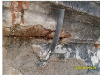
Fotografías; 1, máquina para inyectar. 2, muestra la manguera para ser inyectada, 3, la inyección en la manguera de espera en un muro
