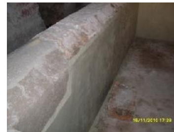
Fotografías 1,2 Fuente: Propia, consolidación en muros del monumento de Santa Clara de La Antigua Guatemala , fotografía 3, Fuente, Propia, Pila del primer claustro del Monumento de Sor Juana de Maldonado y paz, consolidación de muro.
