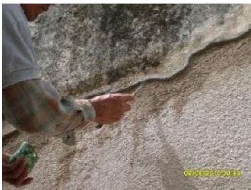
Fotografías 1,2 Fuente: Propia, consolidación en muros del monumento de Santa Clara de La Antigua Guatemala , fotografía 3, Fuente, Propia, Pila del primer claustro del Monumento de Sor Juana de Maldonado y paz, consolidación de muro.
