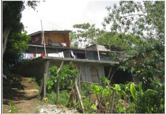
Fotografía No. 8 Módulo de viviendas en el trayecto de ascenso hacia el templo del Calvario, observándose una tipología constructiva a base de madera y lamina de zinc.
