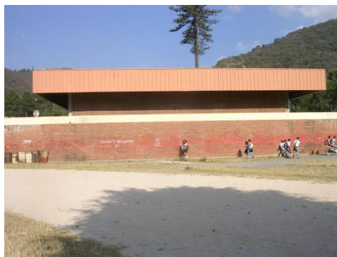
Imagen 40. envoltorio del edificio de salón de usos múltiples, de estructura metálica y cubierto por lámina.
