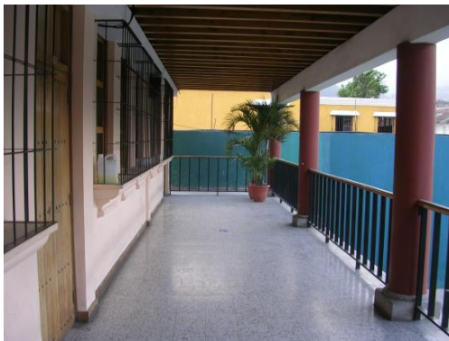
Imagen 54. se observa la utilización de los materiales expuestos como piso de granito y techo tipo terraza española, se utiliza en esta área el sistema tradicional de construcción.
