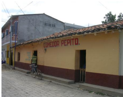
Imagen 17. Comedor Pepito. Otra edificación donde se utiliza teja y adobe en su construcción, se puede observar que tampoco presenta ninguna forma de ventilación e iluminación.
