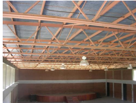
Imagen 42. Estructura metálica y utilización de lámina en cubierta.
