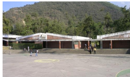
Imagen 34. Área de talleres que se encuentra en una de las alas del edificio, en la plaza central del complejo.
