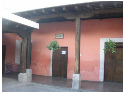
Imagen 55. En ésta área por ser un área protegida no tiene mayores cambios, utilización de adobe en paredes y madera en vigas y columnas, además de presentar una base en columnas de piedra.
