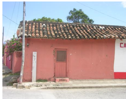
Imagen 16. Casa particular. Casa de adobe donde se utiliza techo de teja y puertas de madera, esta no presenta ventanas al frente, algo inusual tomando en cuenta la región
