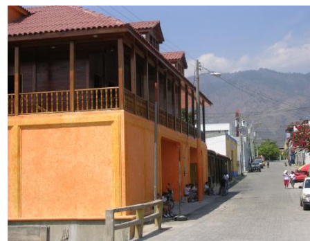
Imagen 22. Casa Particular. Una vista más cercana del edificio, se observa los detalles en madera del segundo nivel, el primer nivel es de adobe con muros gruesos, característico del tiempo de la colonia.
