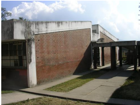
Imagen 41. Se observa la utilización de ladrillo expuesto y el techo hecho de concreto armado.
