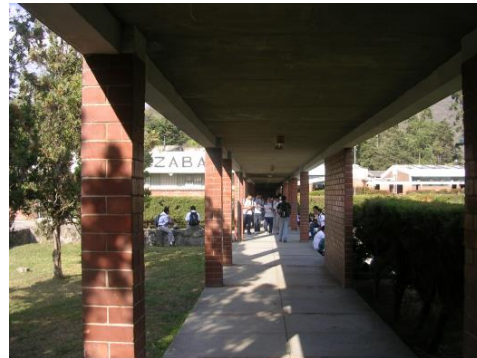
Imagen 39. Pasillo de concreto que comunica entre edificios. Esta hecho de concreto armado y ladrillo expuesto.
