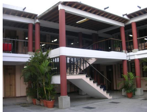
Imagen 47. área educativa de las instalaciones Nuevas.
