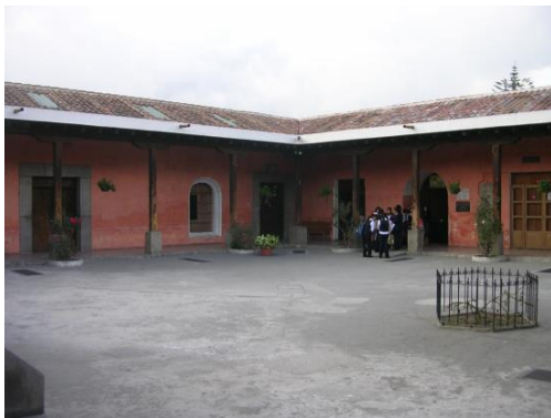
Imagen 46. área educativa de las instalaciones antiguas.
