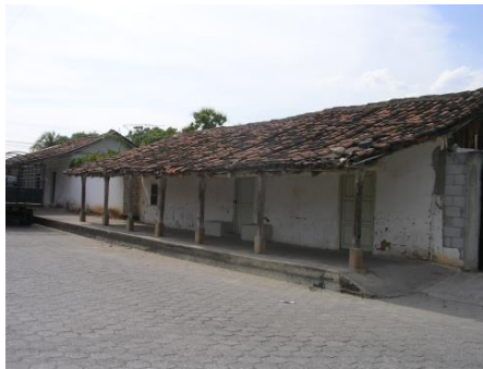
Imagen 19. Casa particular. Ésta es la topología de las casas antiguas en Teculután donde se presenta un pasillo frontal con columnas de madera y sobre ellas descansa un techo a un agua de teja, en algunos casos existe un bloque que sirve a manera de descanso para los habitantes de la casa.
