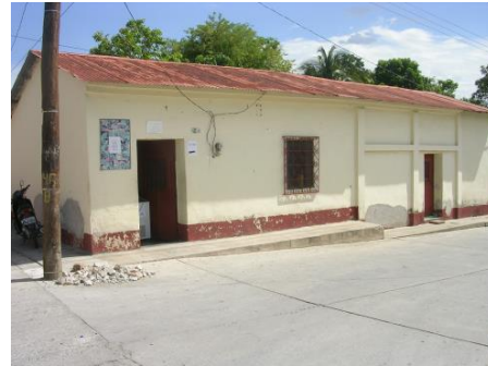
Imagen 18. Casa particular. Ésta es una casa típica de la localidad donde se ve la forma de construcción tradicional, techo de lámina galvanizada y puertas y ventanas de hierro.
