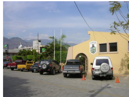
Imagen 28. Municipalidad de Teculután. Exterior de la municipalidad de Teculután, donde se observa que utiliza fachada con un techo a dos aguas con un arco como ingreso principal, se puede observar que maneja un pasillo frontal.
