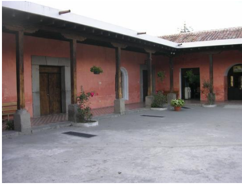
Imagen 52. Paredes verticales y techos a dos aguas, pasillo con terraza española y columnas de madera.
