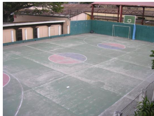
Imagen 49. área deportiva destinada a la cancha polideportiva.
