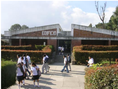
Imagen 38. Paredes verticales y techo a 2 aguas interrumpido por una abertura central donde se encuentra el pasillo.
