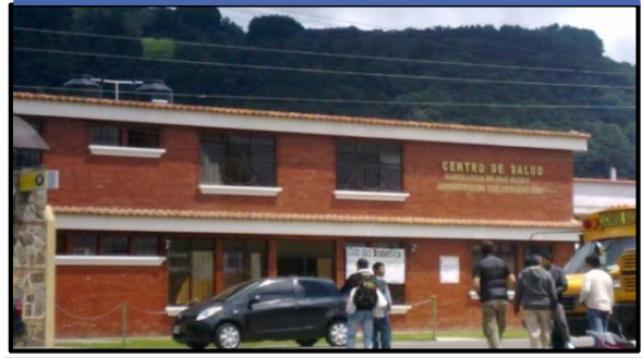
3. CENTRO DE SALUD Por: K Ferrer Año 2011 Su fachada es de ladrillo tayuyo, con ventanales de vidrio, su cubierta de teja en las orillas con techos planos.
