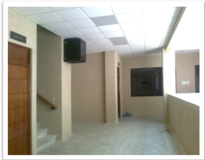
Imagen 08, Modulo de gradas, Segundo nivel.
